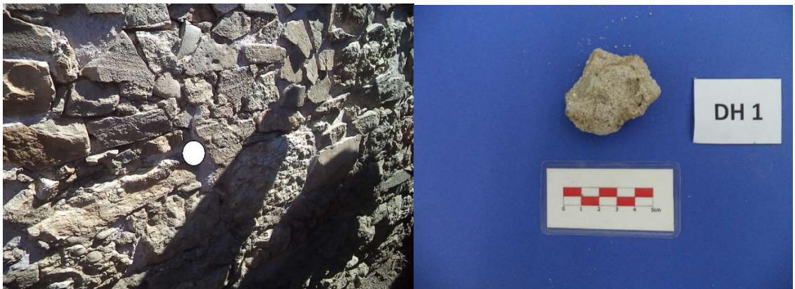
Şekil 3. 34. DH1 kodlu harç numunesi
