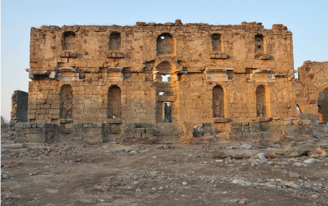
Şekil 3. 1. Çeşme Binası (Nymphaeum)
