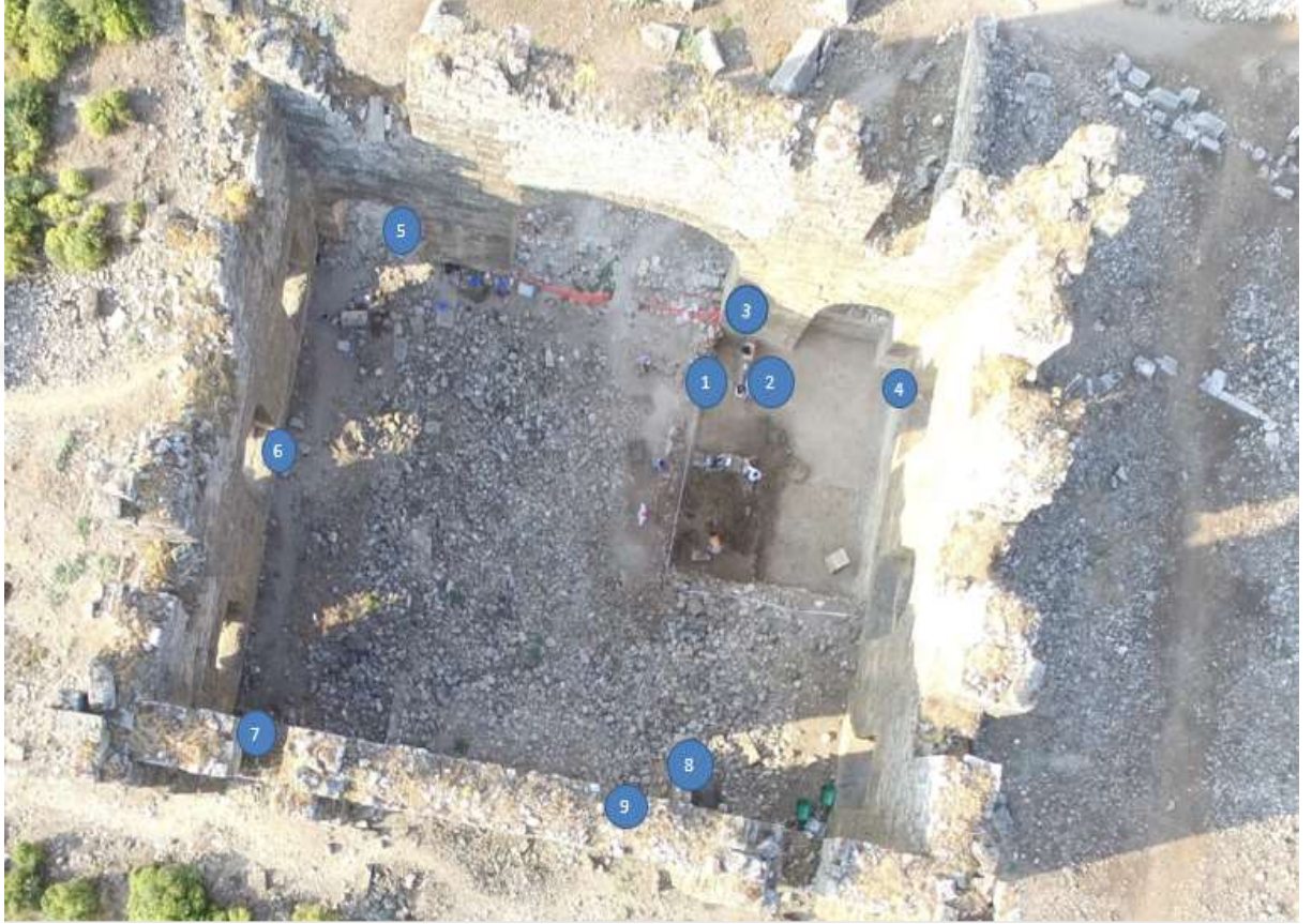
Şekil 3. 23. Bazilika yapısından alınan numunelerin yerleri
