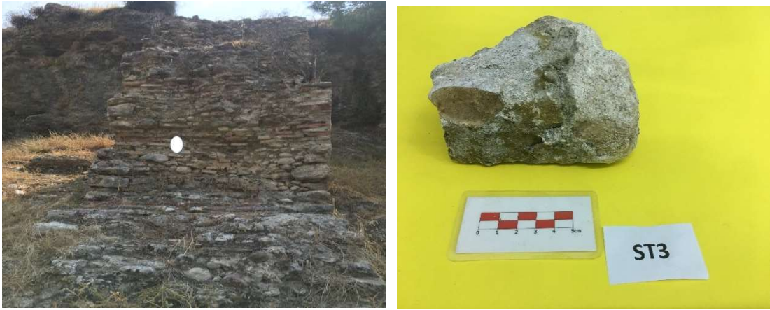
Şekil 3.19. ST3 kodlu tuğla numunesi
