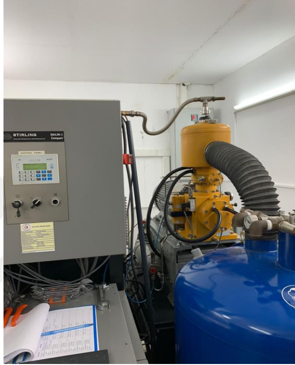
Fotoğraf 4.2. ODTÜ Merkezi Laboratuvar Stirling Sıvı Azot Üretim Sistemi.
