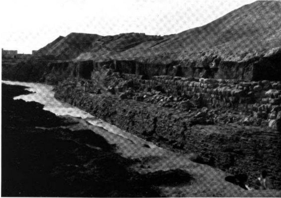
Şekil 4.29: Dicle Nehri'ne paralel uzanan rıhtım duvarı ve kaplama duvarı (Andrae, 1913a, Abb. 267)
