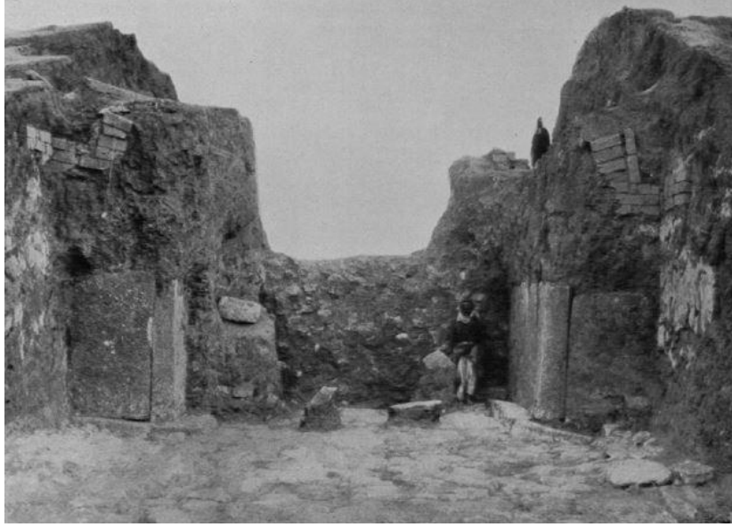
Şekil 4.73: Horsabad'daki Kent Kapısı 7'nin dış geçişinden kabartmasız orthostatlar, kemer ve diğer ayrıntıları (Frankfort, 1936, Fig. 3)
