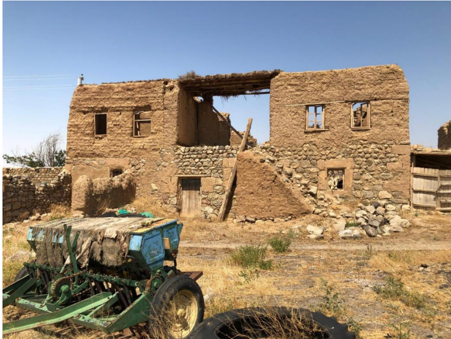
Resim 33: Aksaray Sarayhan Köyünde terkedilmiş iki katlı kerpiç ev. 93
