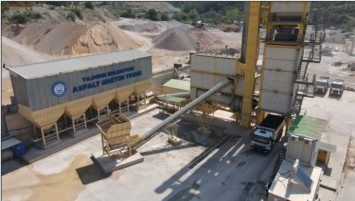
Resim 2.1 Yıldırım Belediyesi agrega ve asfalt üretim tesisi.
