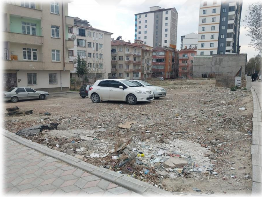
Şekil 3.8. Yıkıntı atığının toplandığı alan
