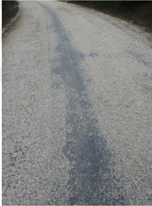
Şekil 2.7. Sathi kaplama agregatı sökümü
