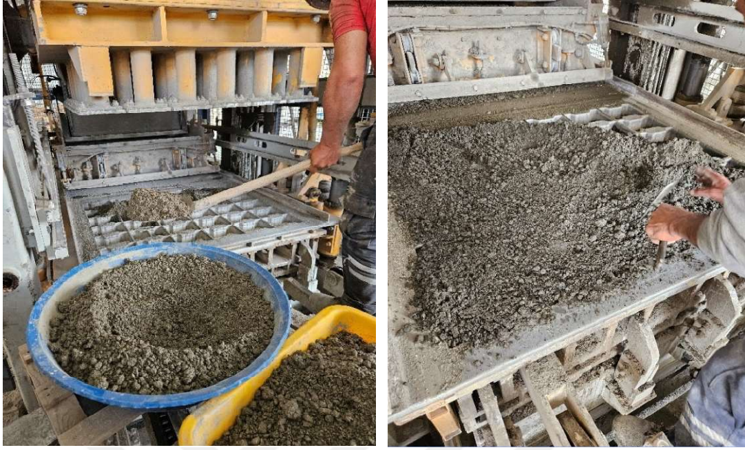
Şekil 3.15. Elle karıştırılan malzemenin kalıplara yerleştirilme aşaması
