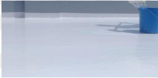
Şekil 1.4. Epoksilerin teras çatı yalıtımında kullanılması
