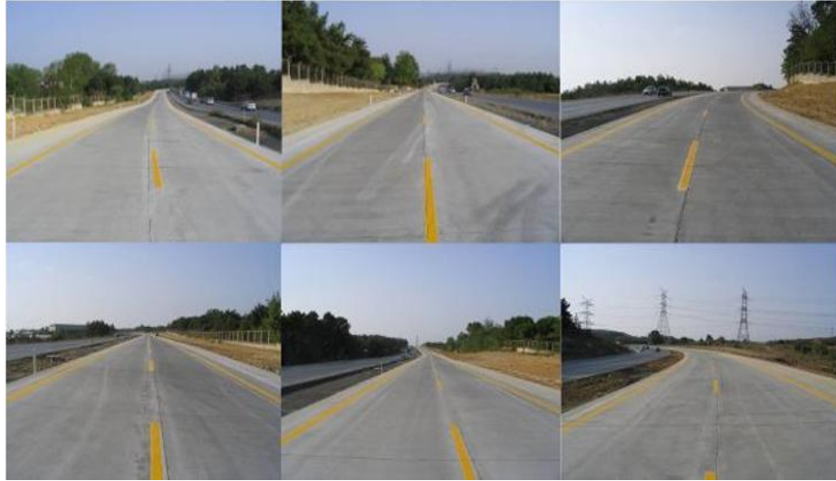
Şekil 1.5. Hasdal Kemberburgaz beton yol görüntüsü
