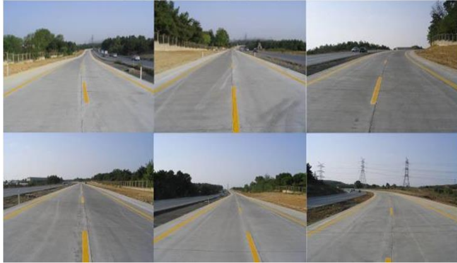
Şekil 1.5. Hasdal Kemberburgaz beton yol görüntüsü
