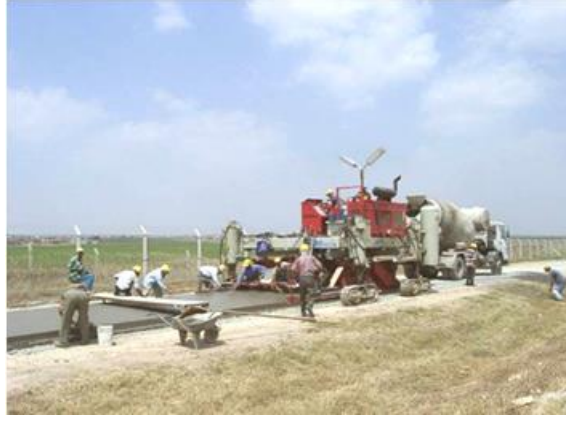
Şekil 1.2. Adana- İncirlik hava üssü çevre güvenlik yolu beton dökümü (Çetin, 2009b)
