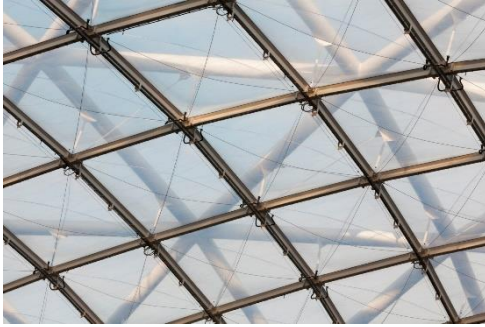
Şekil 2.37. Geri dönüştürülmüş çelikten üretilmiş çatı taşıyıcı sistem örneği (URL-49)
