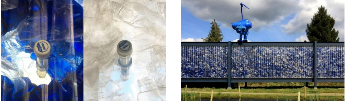
Şekil 2.74. Atık pet şişelerin duvar dolgu malzemesi olarak kullanım örneği (URL-93)
