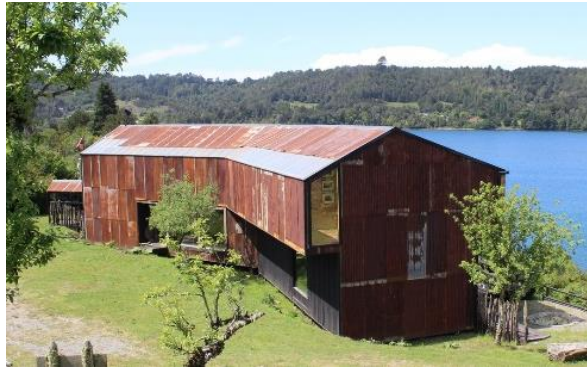
Şekil 2.22. Korozyona uğramış çinko parçalarından çatı kaplama uygulaması (URL-31)
