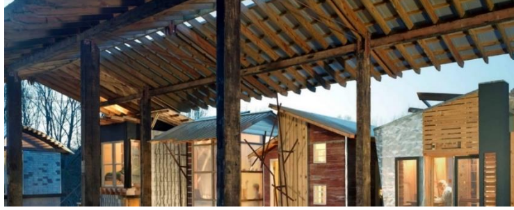
Şekil 2.11. Yapı tadilatı nedeniyle âtıl duruma gelen taşıyıcı ahşap kirişlerin başka bir yapıda yeniden kullanım örneği (URL-15)
