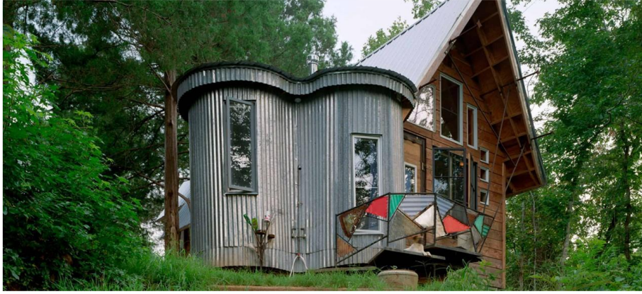
Şekil 2.25. Atıl durumdaki oluklu galvaniz levhanın cephede kullanımı (URL-35)
