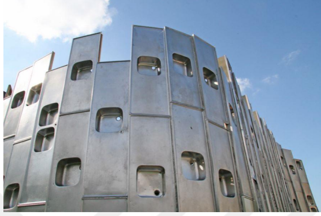
Şekil 2.101. Metal evyelerden cephe kaplama uygulaması örneği (URL-115)
