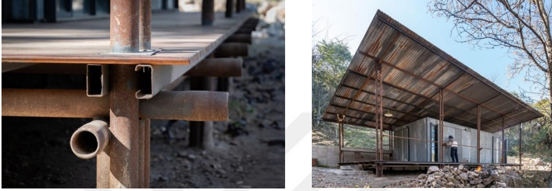
Şekil 2.14. İnşaat atığı olan metal borulardan taşıyıcı kolon uygulama örneği (URL-19)
