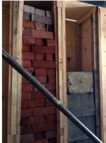
Şekil 2.13. Atıl haldeki tuğlaların cephe dolgu elemanı olarak yeniden kullanımı örneği (URL-18)
