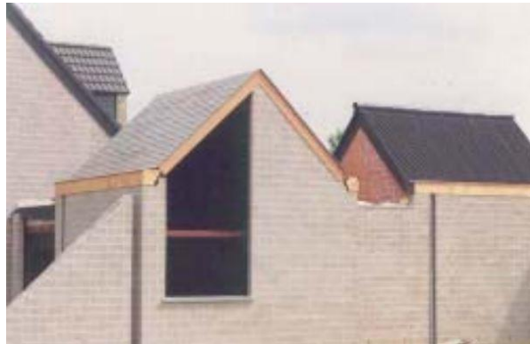
Şekil 2.88. Evsel plastik, kâğıt ve kumaştan oluşturulan kiremit solda, bitüm ve gazete kağıtları ile oluşturulan kiremit sağda (URL-110)
