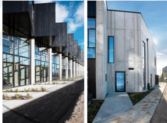
Şekil 2.41. Geri dönüştürülmüş betonarme cephe taşıyıcı uygulama örneği (URL-54)
