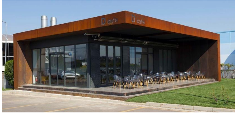
Şekil 2.55. Çelik plaka kaplama uygulama örneği (URL-69)
