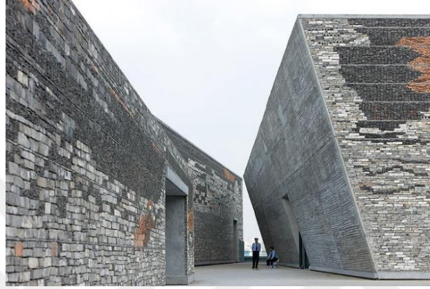
Şekil 2.16. Yıkılan binalardan elde edilen taş malzemenin yeni yapı duvarında kullanım örneği (URL-20)
