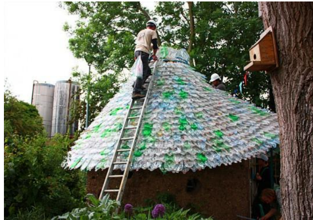
Şekil 2.92. Pet şişelerin çatı kaplama malzemesi olarak kullanım örneği (URL-113)
