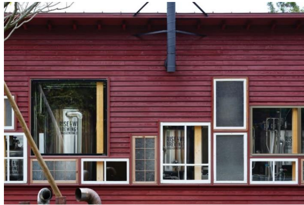
Şekil 2.31. Atık PVC pencerelerin başka bir yapıda yeniden kullanımı örneği (URL-43)
