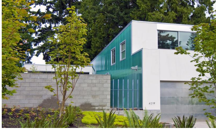
Şekil 2.58. Geri dönüştürülmüş plastikten üretilen polikarbon kaplama (yeşil) (URL-74)
