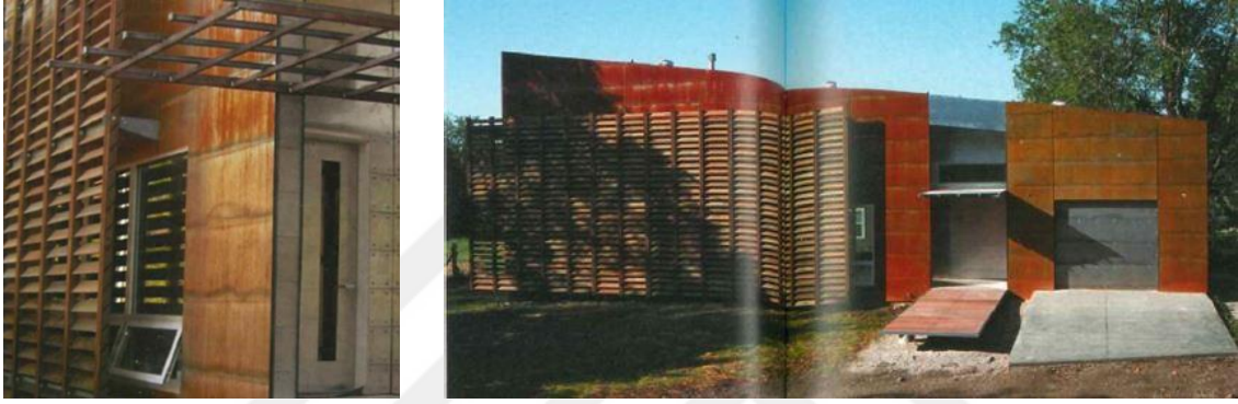
Şekil 2.34. Kullanılmış ahşap çıtalardan güneş kırıcı panel tasarımı (Bahamon ve Sanjines, 2010, s. 135)
