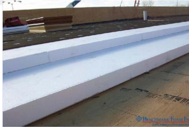
Şekil 2.49. Geri dönüştürülmüş EPS' nin teras çatı üzerinde uygulama örneği (URL-63)
