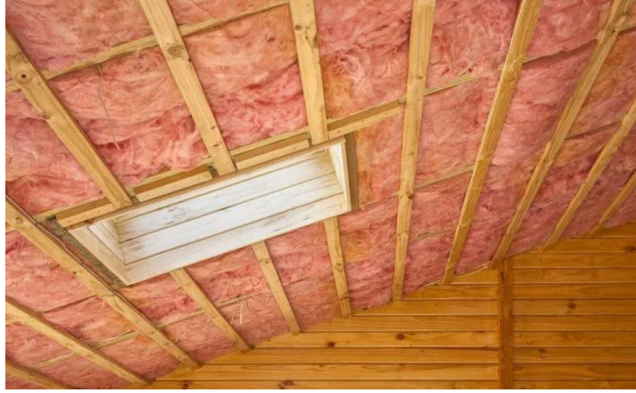
Şekil 2.48. Geri dönüştürülmüş ahşap ve kenevir yalıtım uygulama örneği (URL-62)
