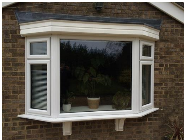
Şekil 2.63. Geri dönüştürülmüş PVCu' den üretilen yeni pencere örneği (URL-78)
