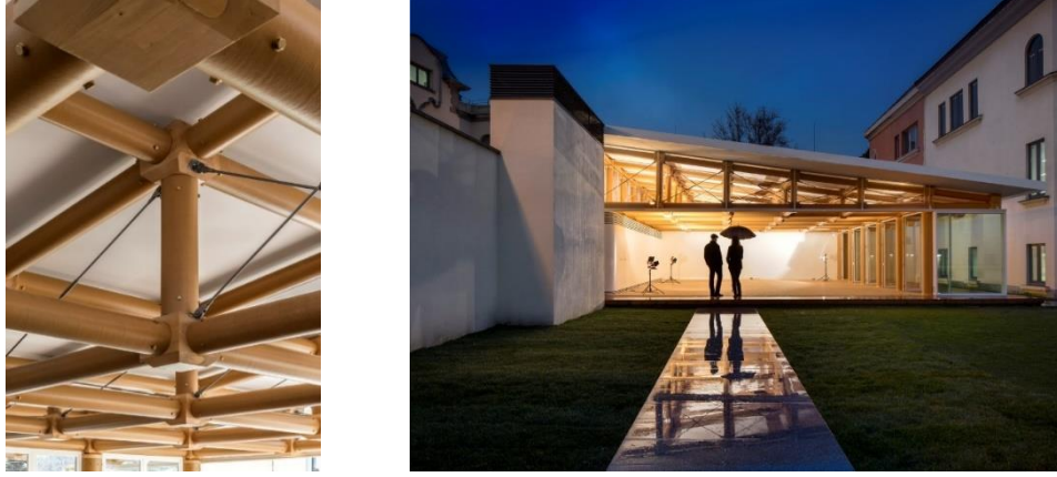
Şekil 2.68. Karton tüplerden çatı kirişi uygulama örneği (URL-83)
