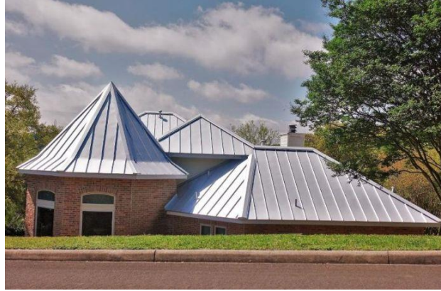
Şekil 2.61. Geri dönüştürülmüş metallere üretilen metal çatı kaplama örneği (URL-76)
