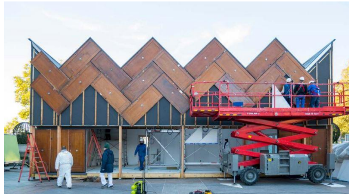
Şekil 2.29. Atık ahşap kapıların başka bir yapıda cephe kaplaması olarak kullanım örneği (URL-38)
