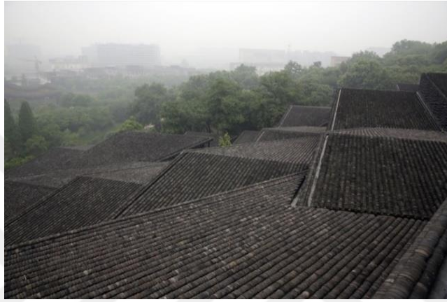
Şekil 2.23. Atıl durumdaki kiremitlerin başka bir yapıda çatı kaplaması olarak yeniden kullanım örneği (URL-32)
