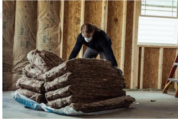
Şekil 2.53. Geri dönüştürülmüş taş yalıtım malzemesi uygulama örneği (URL-66)
