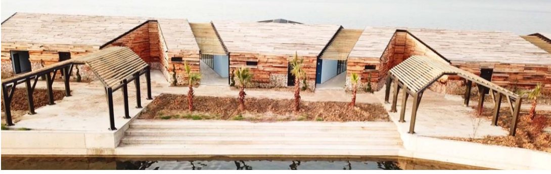
Şekil 2.24. Atıl durumdaki ahşap kalıp parçalarının başka bir yapıda çatı ve cephe kaplaması olarak yeniden kullanım örneği (URL-34)
