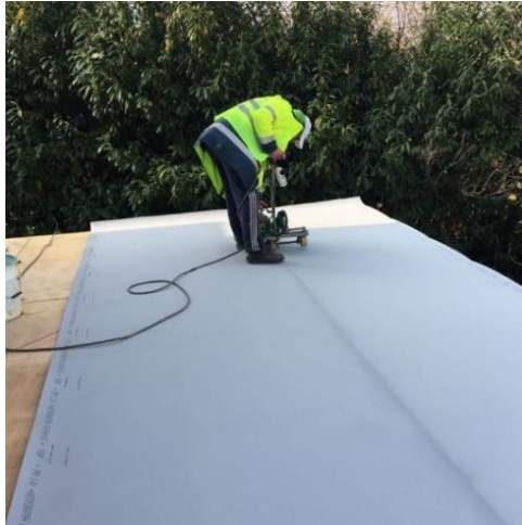
Şekil 2.20. EPDM Yalıtım malzemesi uygulama örneği (URL-28)
