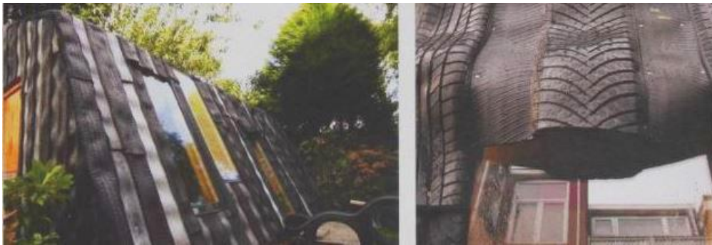
Şekil 2.90. Araba lastiklerinin yapı çatısında kullanım örneği (Bahamon ve Sanjines, 2010, s. 115)
