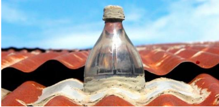
Şekil 2.99. Atık pet şişelerden oluşturulan çatı ışıklık örneği (Kahraman, 2015)
