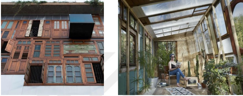
Şekil 2.32. Atık ahşap pencerelerin başka bir yapıda cephe ve çatı penceresi olarak yeniden kullanımı örneği (URL-44) (URL-45)
