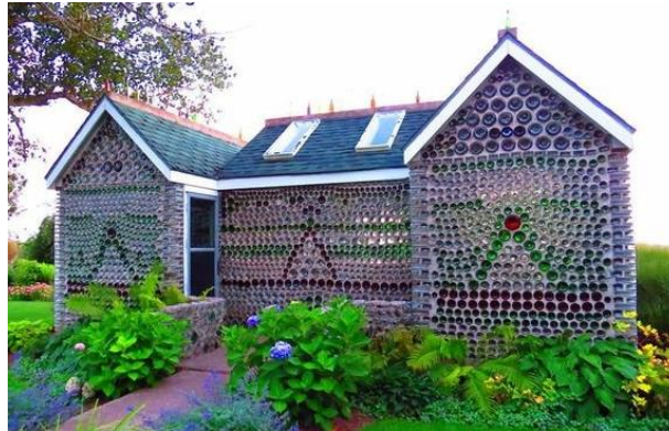
Şekil 2.77. Atık cam şişelerin duvar dolgu elemanı olarak kullanımı örneği (URL-97)
