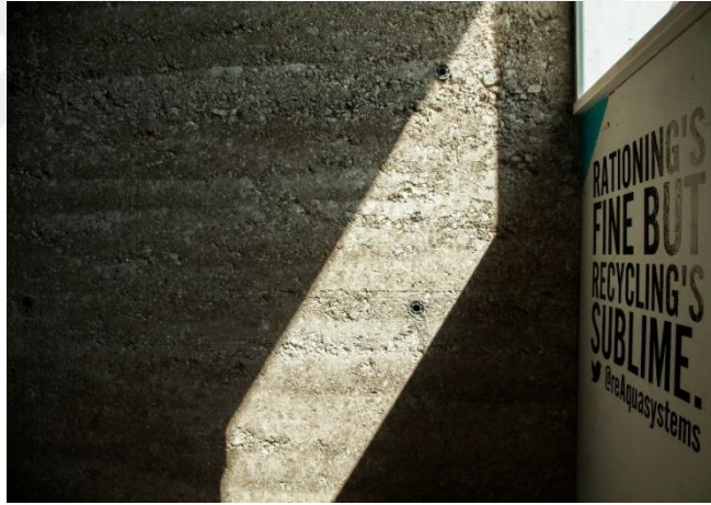
Şekil 2.71. Tebeşirden yapılan taşıyıcı duvar örneği (URL-87)
