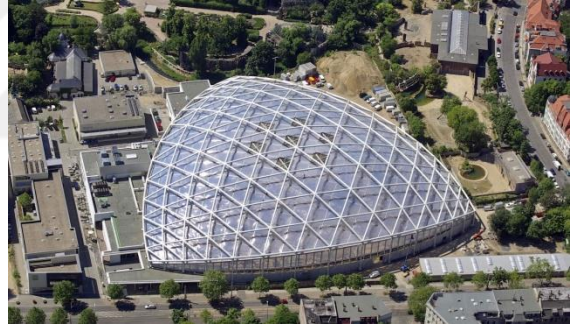
Şekil 2.37. Geri dönüştürülmüş çelikten üretilmiş çatı taşıyıcı sistem örneği (URL-49)
