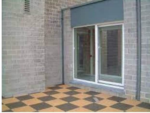
Şekil 2.42. Geri dönüştürülmüş polistrenden duvar dolgu elemanı terracotta blok (URL-55)
