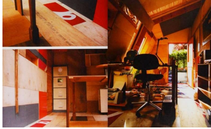
Şekil 2.26. Kontraplak levhaların eski bir yapıdan sökülerek yeni yapıda duvar iç kaplaması olarak kullanımı örneği (Bahamon ve Sanjines, 2010, s. 135)
