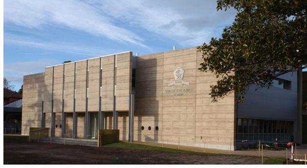
Şekil 2.40. Geri dönüştürülmüş taş atıktan tuğla dolgu duvar (URL-53)
