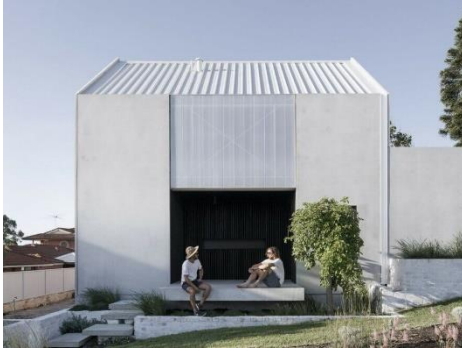
Şekil 2.39. Geri dönüştürülmüş beton paneller ile yapılmış çatı ve cephe uygulaması örneği (URL-52)
