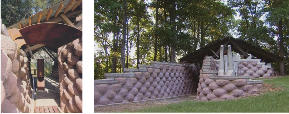
Şekil 2.72. İçi toprak dolgu lastikler ile oluşturulan duvar örneği (lastikler sıva ile kapatılmıştır) (URL-89)
