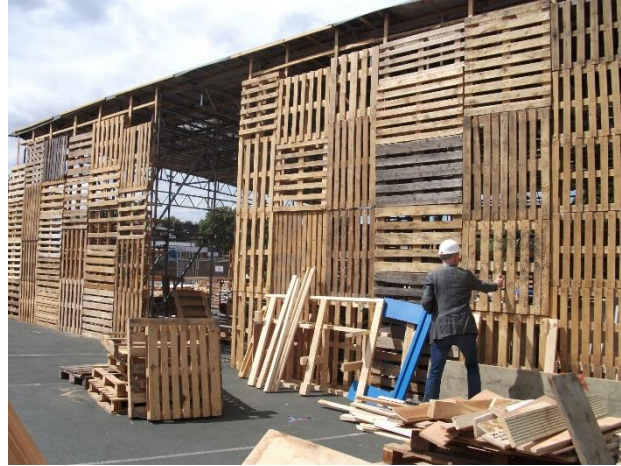
Şekil 2.27. Ahşap paletlerin cephe kaplama malzemesi olarak kullanımı örneği (URL-37)
