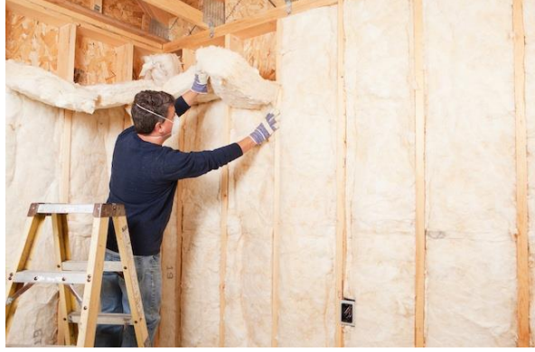
Şekil 2.19. Fiberglass yalıtımın başka bir yapıda yeniden kullanım örneği (URL-26)
