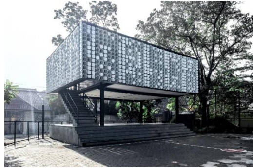
Şekil 2.100. Plastik dondurma kaplamalarından yapılan cephe kaplama örneği (URL-117)
