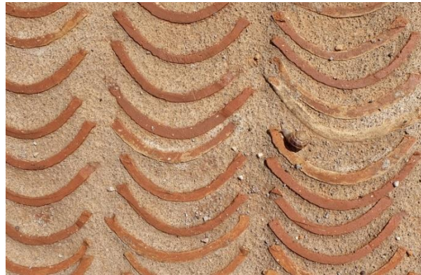
Şekil 2.17. Kiremitlerin dolgu malzemesi olarak kullanım örneği (URL-22)
