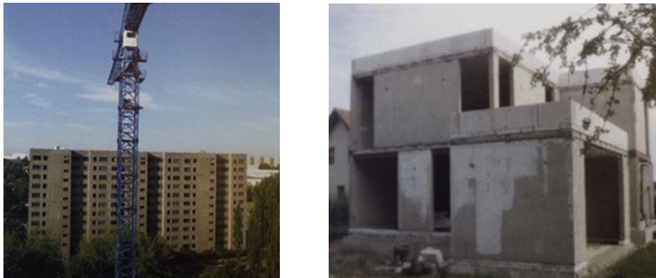
Şekil 2.15. Prekast beton panellerin yapıda kullanım ömrünü tamamlaması sonucu başka bir yapıda yeniden kullanım örneği (Salama, 2017)
