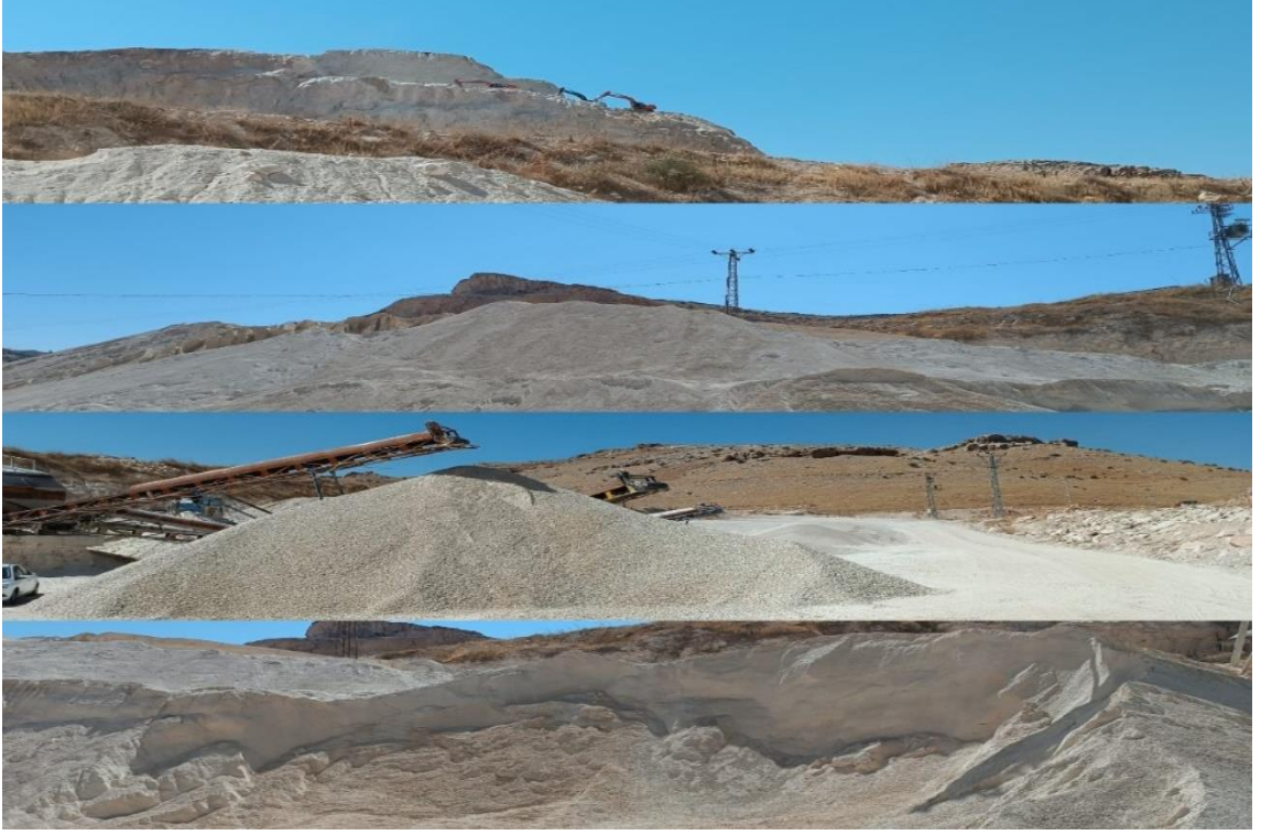
Şekil 0.1. Mardin Türkmen deresi şantiyesi
