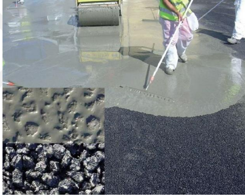
Şekil 1.4. Yarı rijit yol kaplama uygulaması [110]
