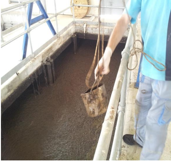
Şekil 2.6. Belediye Atık Su Arıtma Tesisi geri devir çamur ve son çökeltim ünitesi
