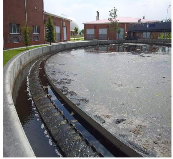
Şekil 2.6. Belediye Atık Su Arıtma Tesisi geri devir çamur ve son çökeltim ünitesi
