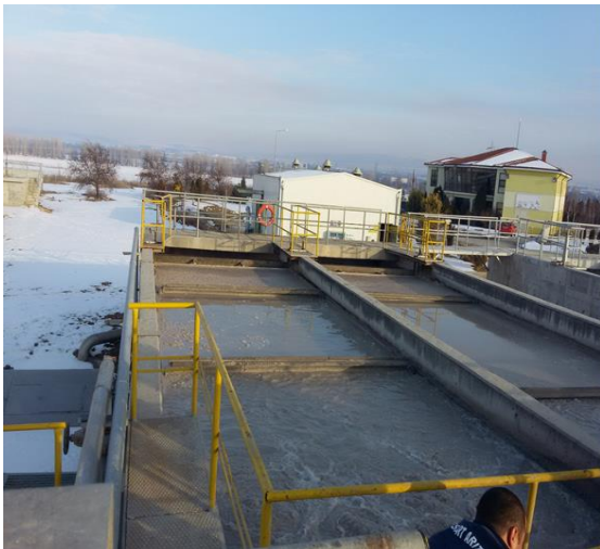
Şekil 2.8. Endüstriyel Atık Su Arıtma Tesisi kum tutucu ve ön çökeltim ünitesi
