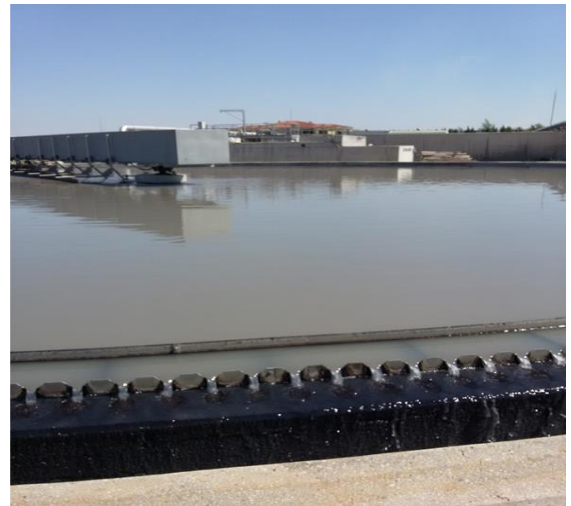
Şekil 2.8. Endüstriyel Atık Su Arıtma Tesisi kum tutucu ve ön çökeltim ünitesi
