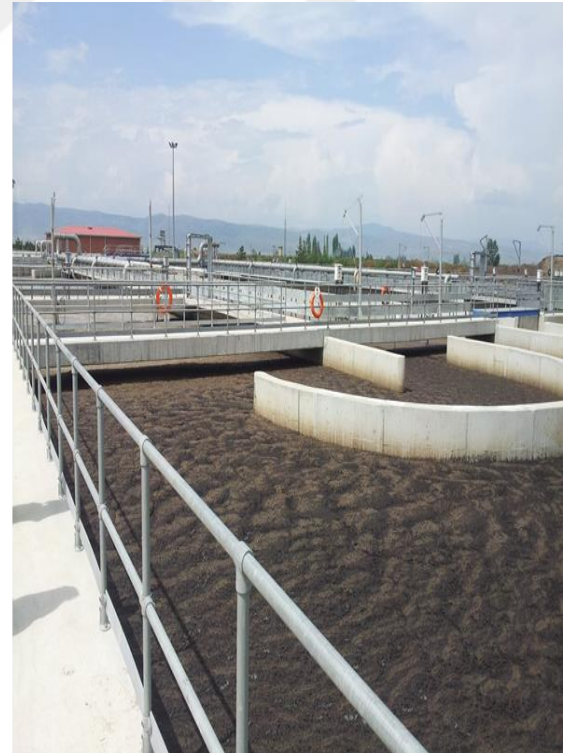
Şekil 2.5. Belediye Atık Su Arıtma Tesisi ön çökeltim ve havalandırma ünitesi
