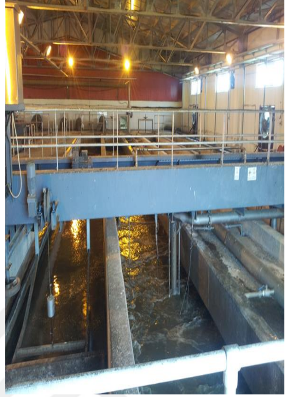
Şekil 2.4. Belediye Atık Su Arıtma Tesisi giriş ve kum yağ tutucu ünitesi
