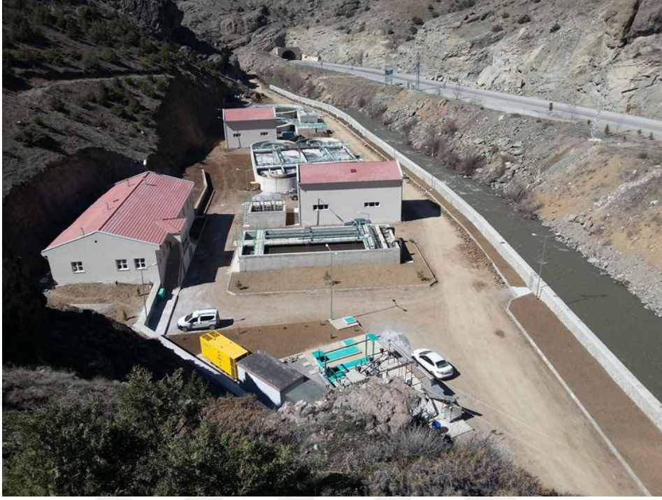
Şekil 13. Gümüşhane Atık Su Arıtma Tesisi
