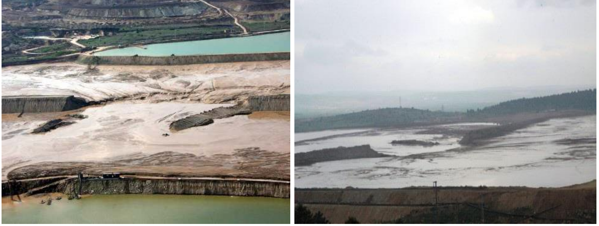
Şekil 3. Atık barajı yıkılması sonucu oluşan görüntü (Gümüşköy gümüş madeni)
