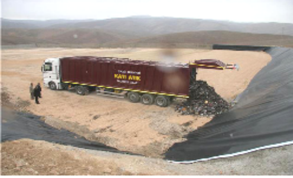
Şekil 3 : Düzenli Depolama Sahası Örneği
