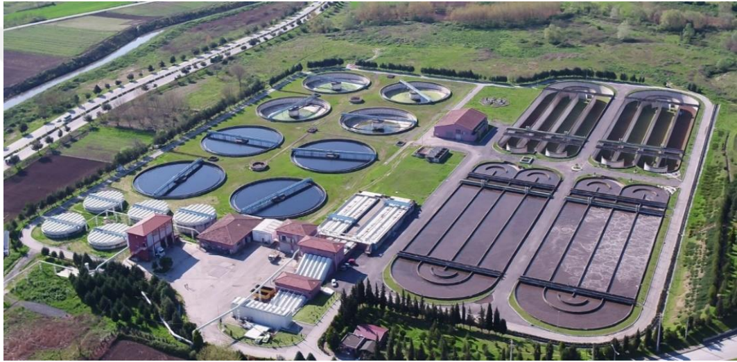
Şekil 5.9. Karaman Atıksu Arıtma Tesisi
