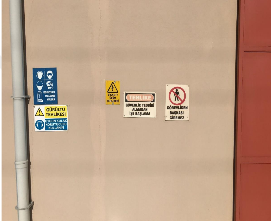
Resim3. 12 Blower Binası Uyarı Levhaları
