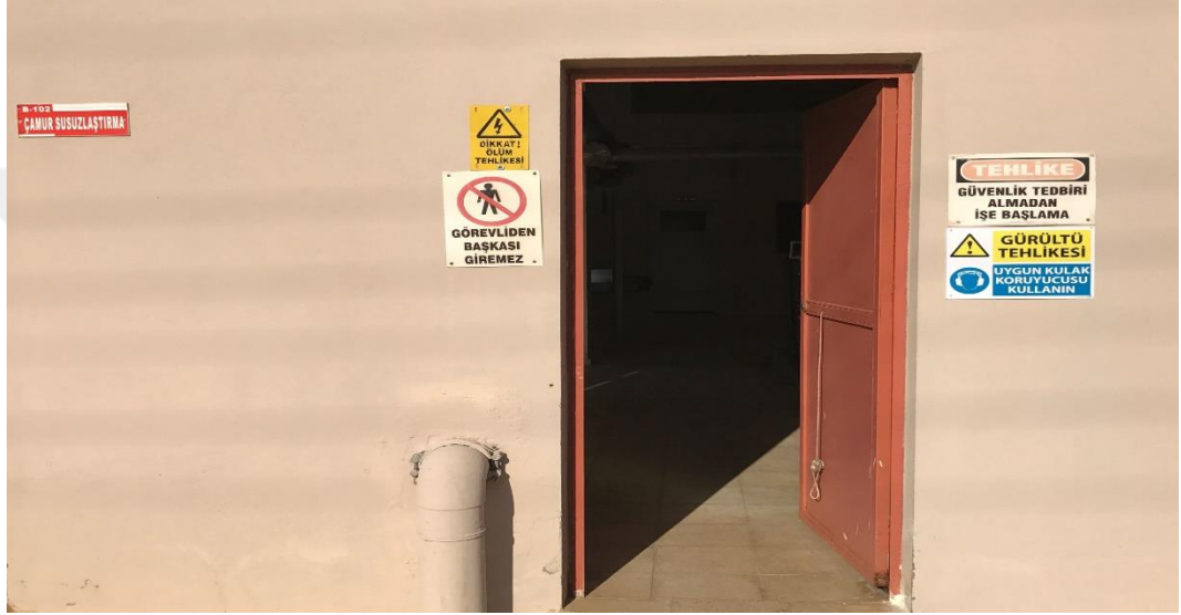
Resim3. 14 Çamur Susuzlaştırma Binası Uyarı Levhaları
