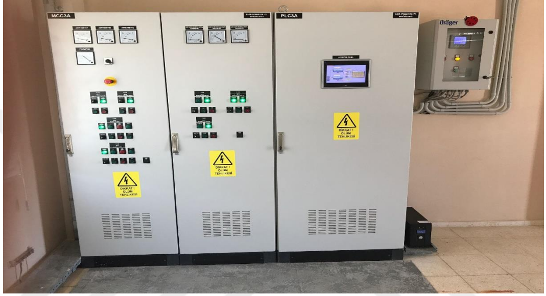
Resim3. 25 Geri Devir Ünitesi Otomasyon Panosu
