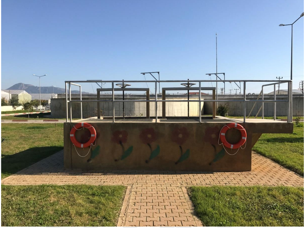
Resim3. 21 Çökeltme Dağıtım Yapısı
