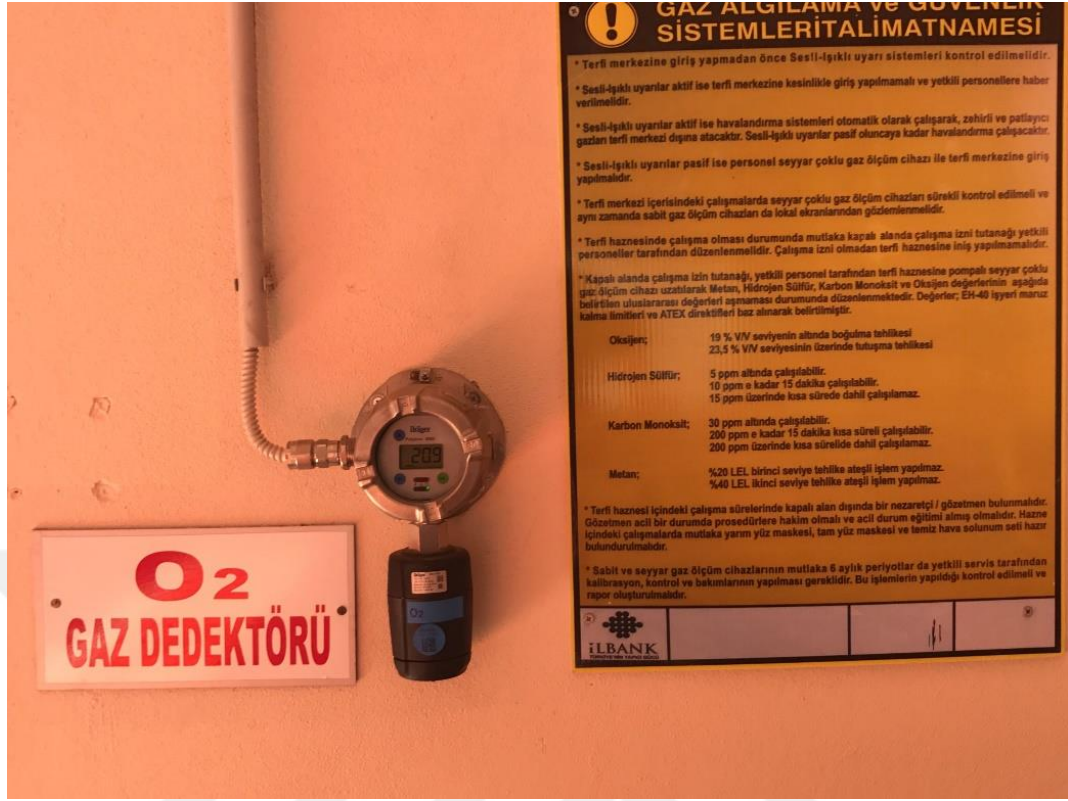
Resim3. 4 Giriş Terfi Ünitesi Gaz Dedektörü
