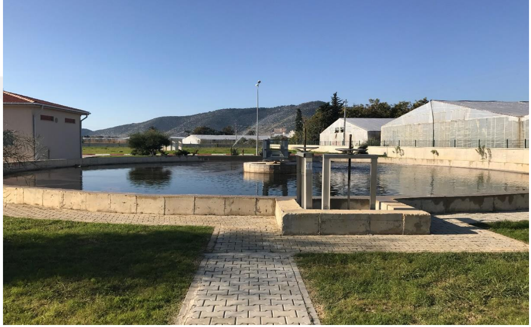
Resim3. 20 Çökeltme Havuzu Ünitesi
