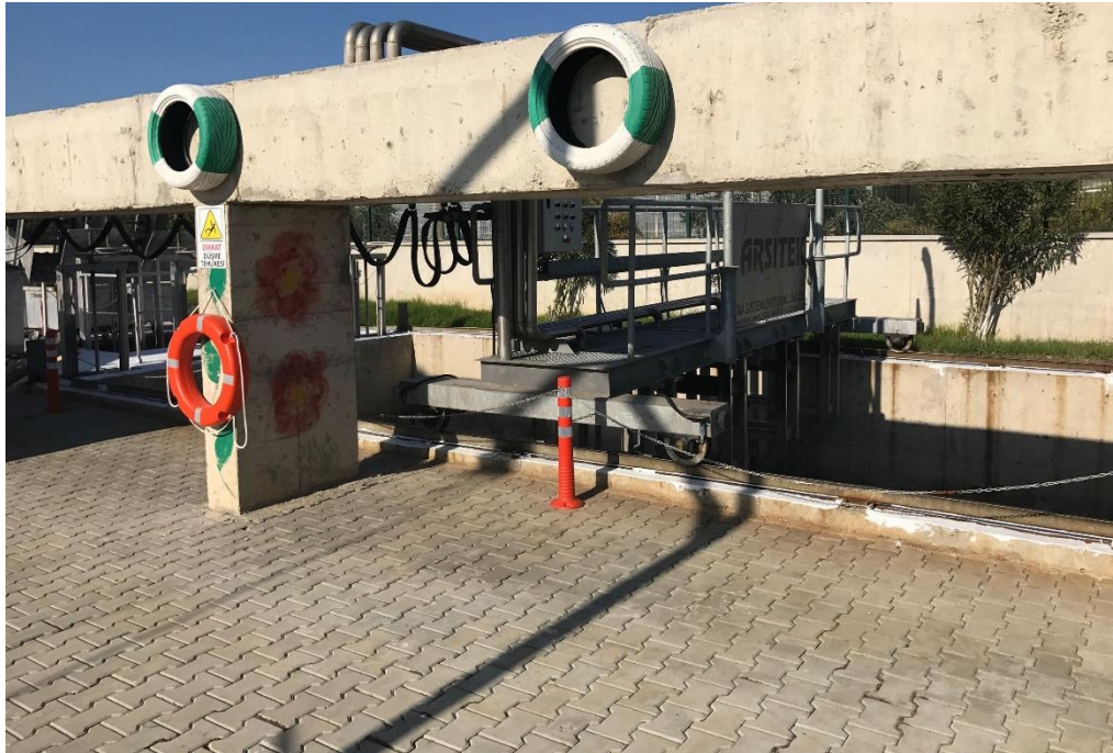
Resim3. 7 Kum ve Yağ Tutucu Ünitesi Alınan Önlemler
