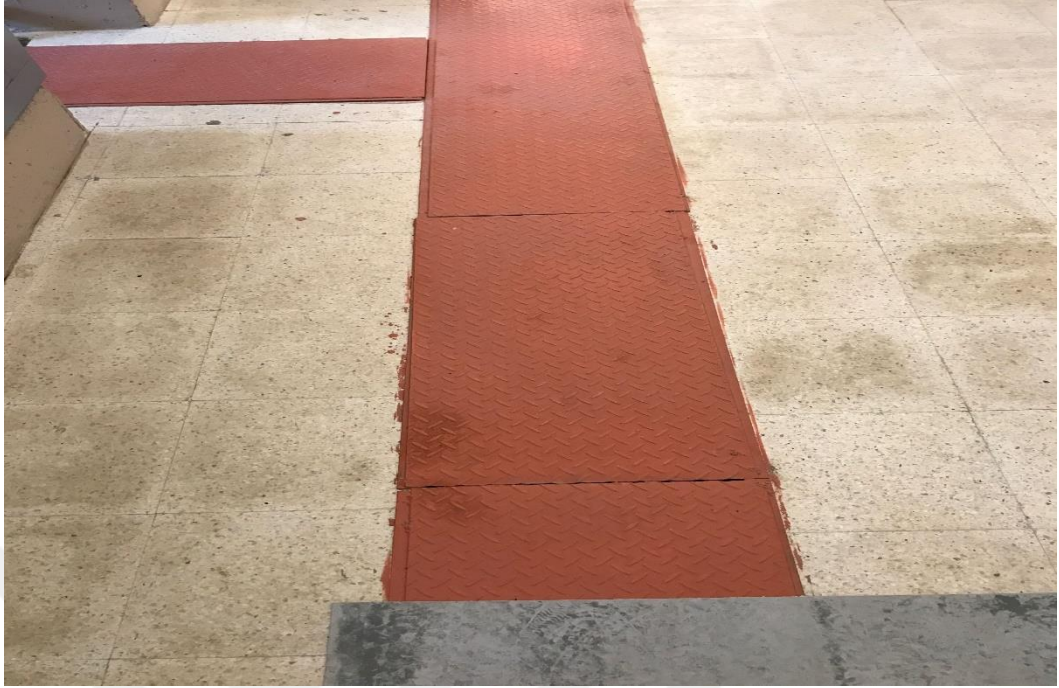
Resim3. 13 Blower Ünitesi Kablo Tavaları
