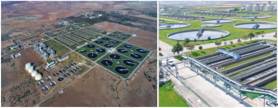
Şekil 3.12. Tatlar Atıksu Arıtma Tesisi genel görünüş (URL-7).
