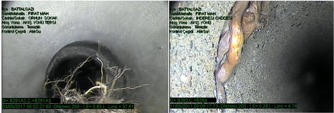
Şekil 4.9. Yapısal Kusurlar, Ağaç ve Bitki Kökleri (MASKİ, 2018)
