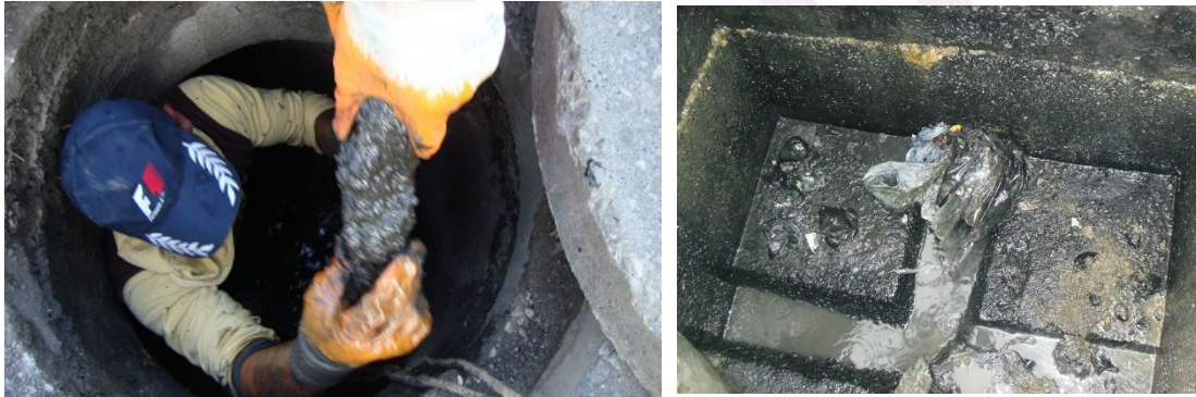
Şekil 3.3. Kanalizasyon sistemlerinde meydana gelen tıkanmalarda, manuel temizlik işlemleri gerektiren olayların örnekleri.
