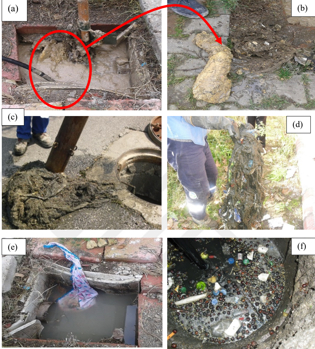
Şekil 1.1. Kanalizasyon tıkanmalarının giderilmesi sırasında belirlenen ve tıkanmalar sebep olan maddelere örnekler. (a) Kızartma yağlarının atıksudaki diğer maddelerle birleşerek oluşturduğu çok sert çökelekler, (b) Yağlarla oluşan çökeleklerin yakından çekilmiş fotoğrafı, (c) Sıradan bir kanal açma çalışması sırasında ortaya çıkan karışık atıklar: Tuvalet kağıdı, ıslak mendil vb. atıkların birleşmesiyle oluşmuş bir yığın, (d) Bir kanal açma çalışması sırasında ortaya çıkarılan atıklar: Tuvalet kağıdı, ıslak mendil, ambalaj atıkları, ve sokak süprüntülerinin birleşmesiyle oluşmuş bir yığın, (e) Bebek battaniyesi, (f) Kabuklu kuruyemiş (fındık), meyve, sebze, ve plastik parçalar gibi atıkların birleşmesiyle meydana gelmiş bir tıkanma olayı.
