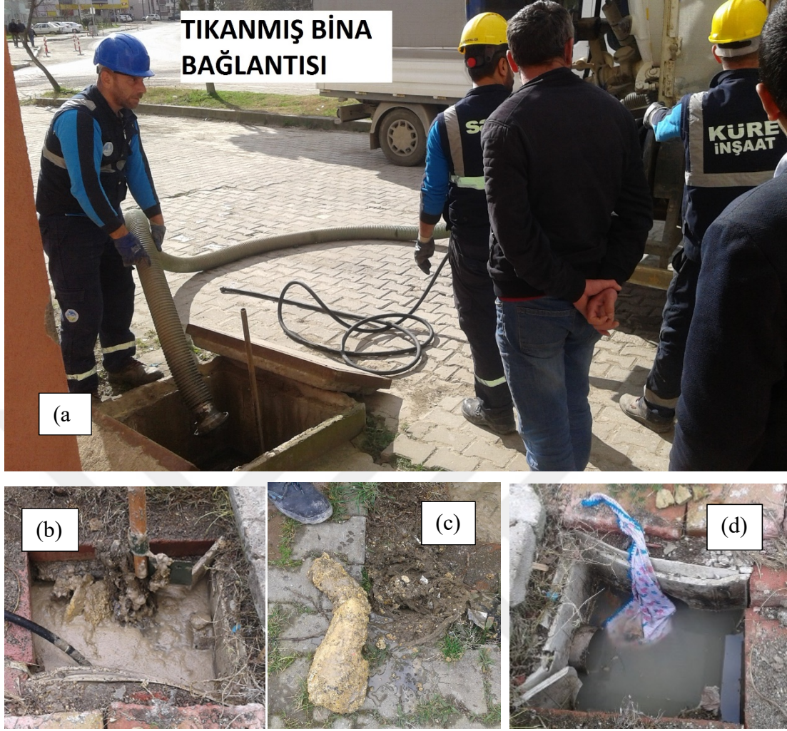
Şekil 4.3. Bina bağlantı bacalarına, ve bu bacalarda meydana gelen tıkanma olaylarının sebeplerine örnekler. (a) Parsel bacası, (b) Evlerden gelen atık yağların meydana getirdiği katı oluşumlar, (c) Yağların meydana getirdiği katı oluşumlar, (d) Bebek malzemelerinin hatalı şekilde bağlantı noktasında toplanması.
