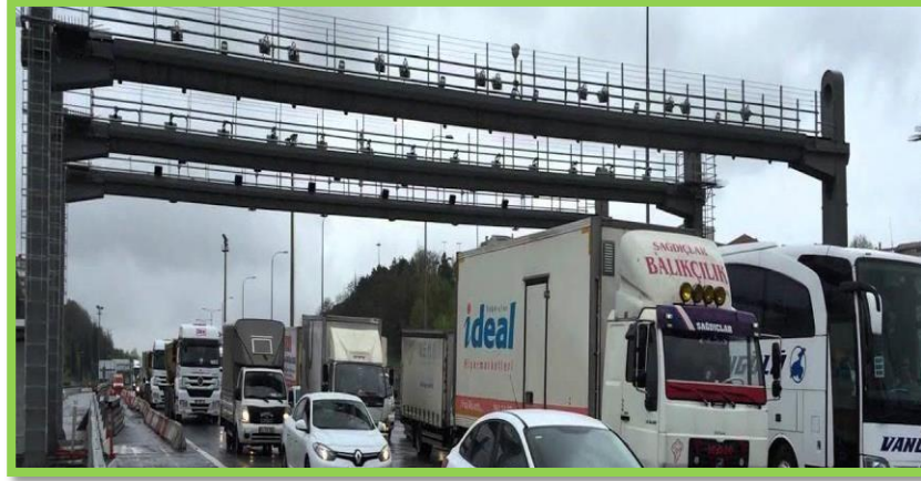
Şekil 2-31: Serbest geçiş ücret toplama sistemi
