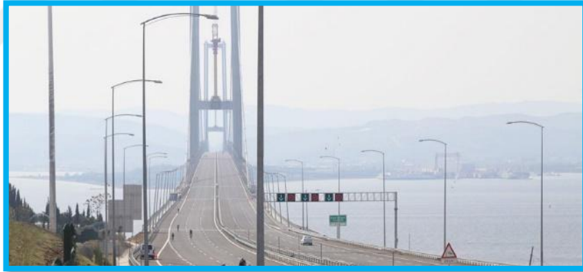
Şekil 2-36: Osmangazi köprüsü SCADA ve otomasyon sistemi
