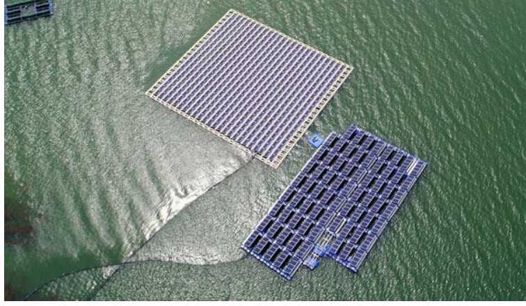
Şekil 3: Yüzer Güneş Enerji Sistemleri
