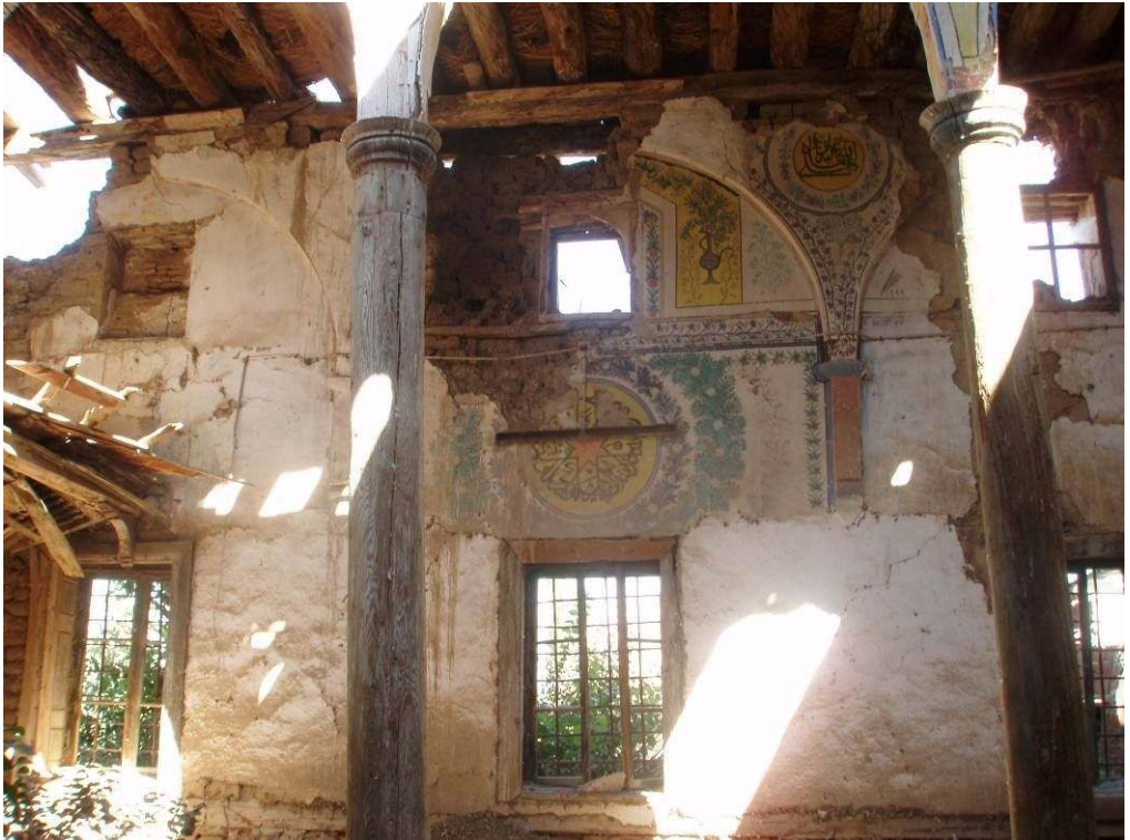
Fotoğraf – 298 – Çivril Savranşah Cami Doğu Duvarı
