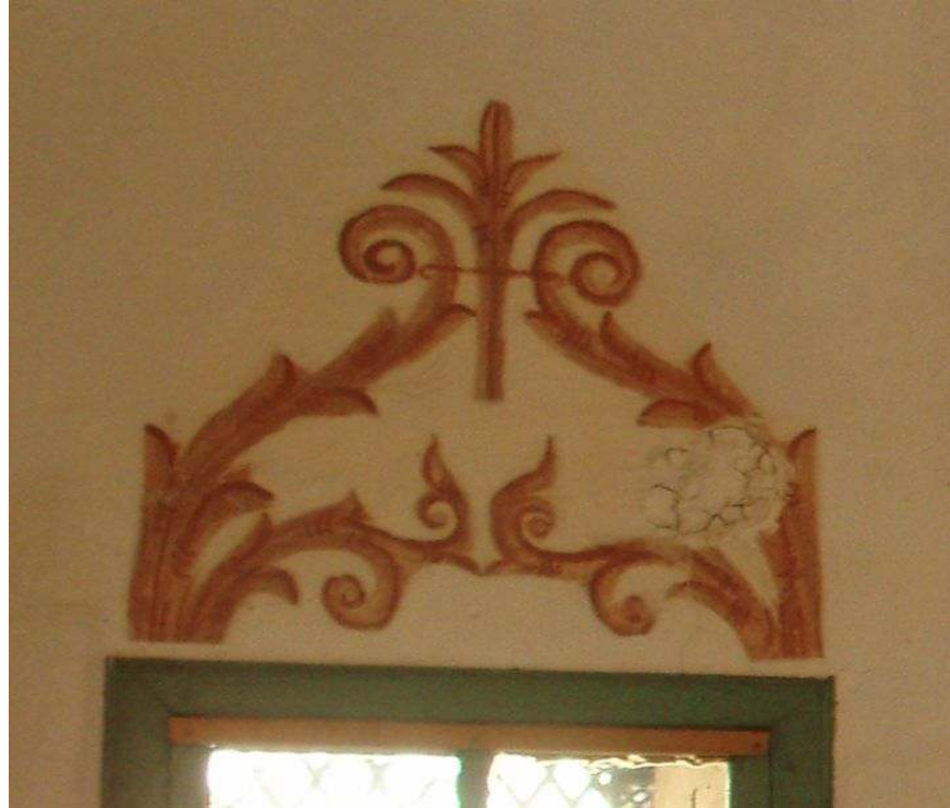
Fotoğraf – 202 – Koçarlı Cincin Köyü Cihanoğlu Camii Doğu Duvarında Üst Pencere Üzerinde Yer Alan Süsleme
