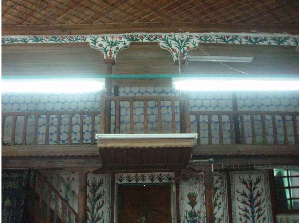
Fotoğraf – 410 – Akköy Yukarı Camii Kuzey Duvarı Genel
