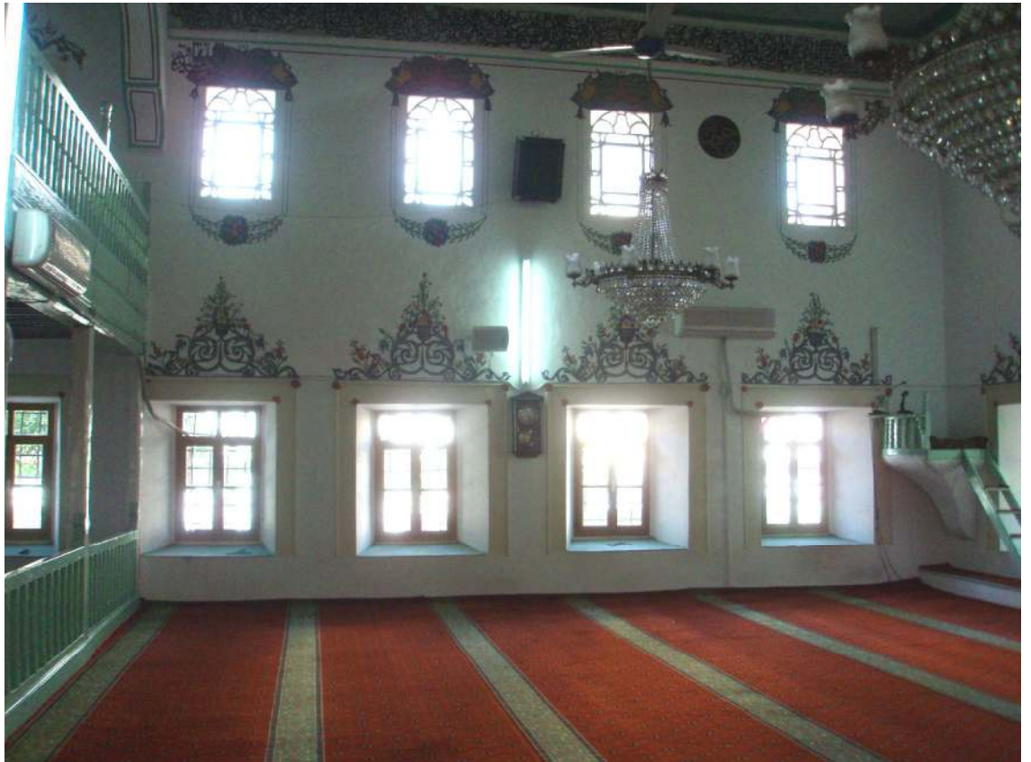
Fotoğraf – 54 – Hacı Ali Ağa Camii (Çarşı Camii) Doğu Duvarı
