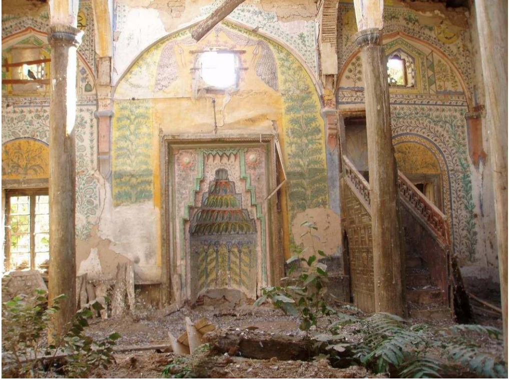
Fotoğraf – 297 – Çivril Savranşah Cami Güney Duvarı
