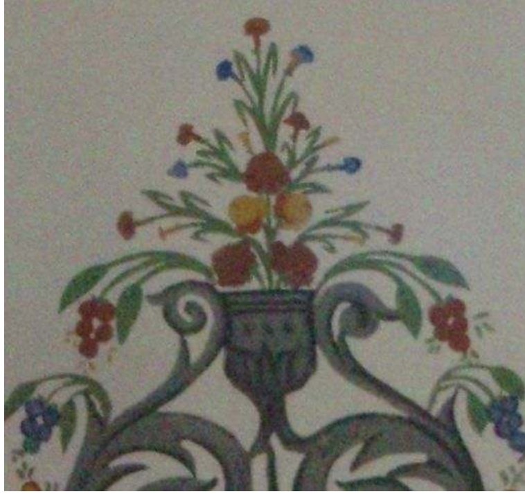
Fotoğraf – 58 – Hacı Ali Ağa Camii (Çarşı Camii) Batı Duvarındaki Alt Pencere Üzerindeki Süsleme Detay
