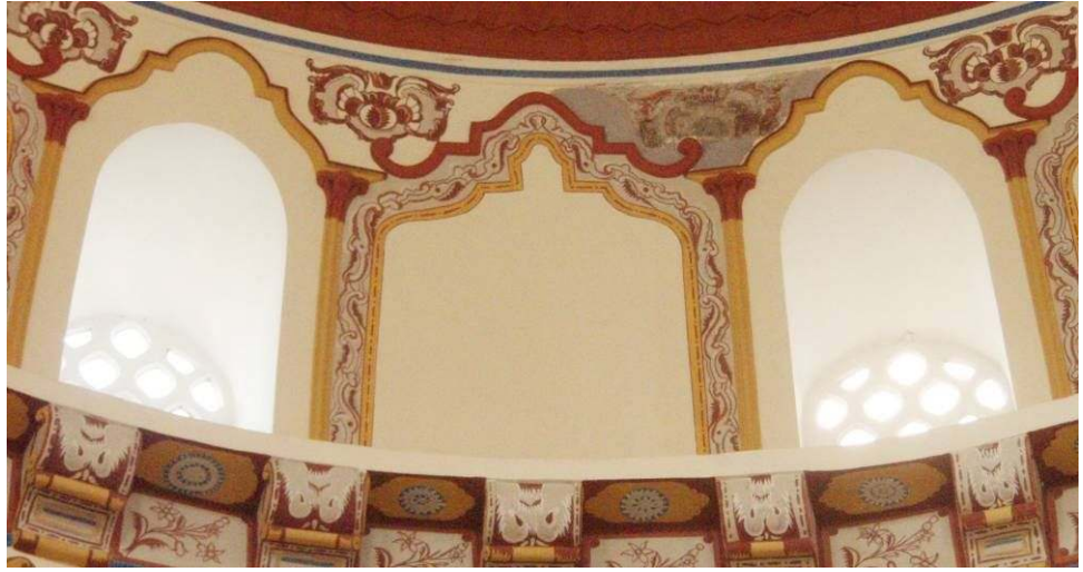
Fotoğraf – 153 – Cihanoğlu Camii Kubbeye Geçişte Yer Alan Pencere Ve Üzerlerindeki Süslemeler
