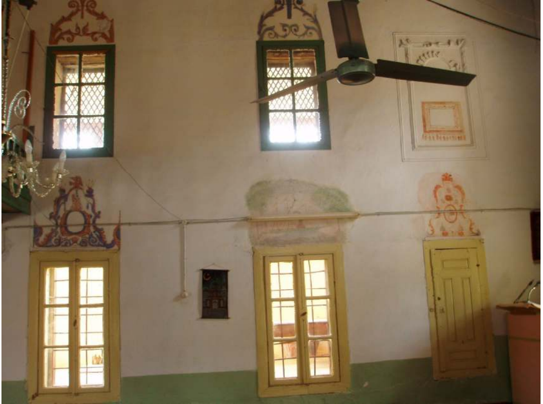
Fotoğraf – 171 – Koçarlı Cincin Köyü Cihanoğlu Camii Doğu Duvarı
