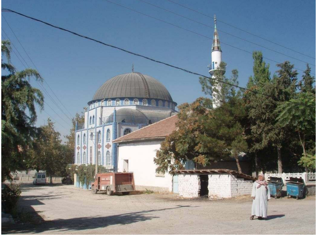
Fotoğraf – 237 – Baklan Boğaziçi Camii Güney Dış Cepheden Görünüşü
