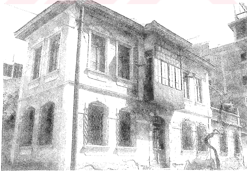
Resim 5.11. Ayře Akyüz Evi Bozulmamış Cephe Düzeni
