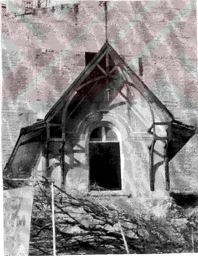
Resim 4.35. Şehir Klübü Binası Çatı Katı Görünümü
