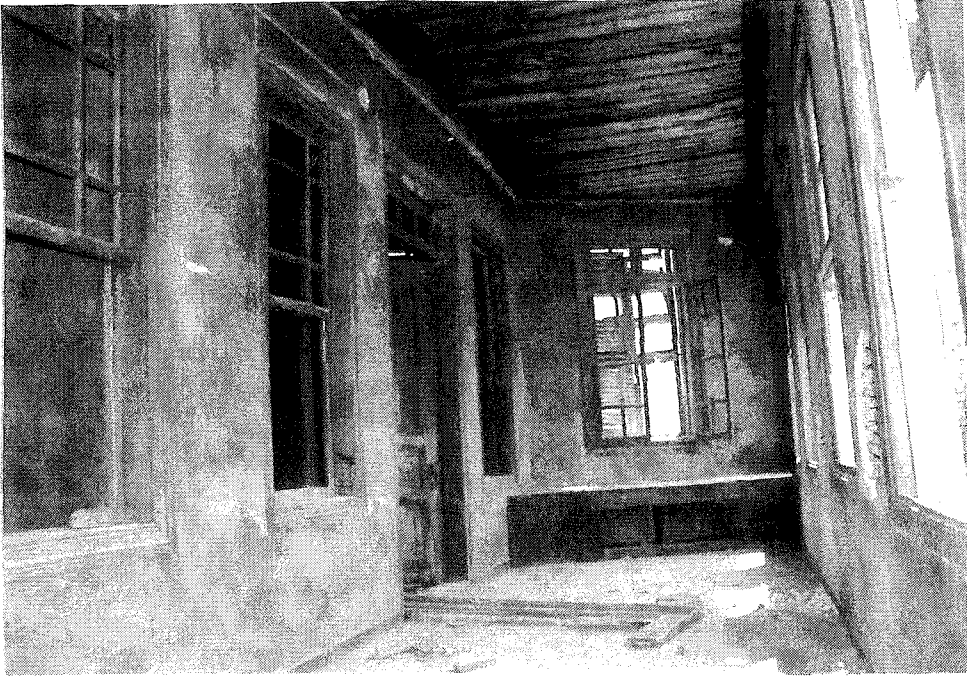
Resim 4.19. 88 Katalog nolu evin arka cephesi
