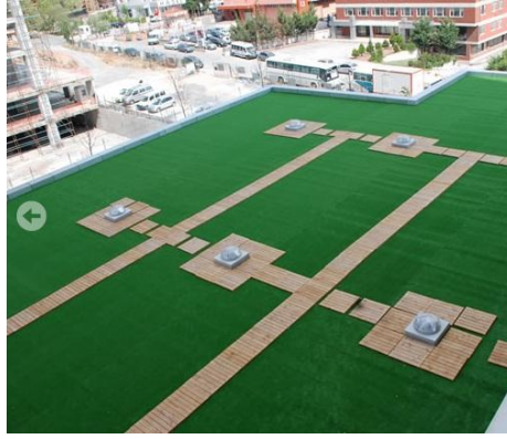
Şekil 4.1.4 Güneşli Tüpleri' nin çatıdaki yerleşimi
