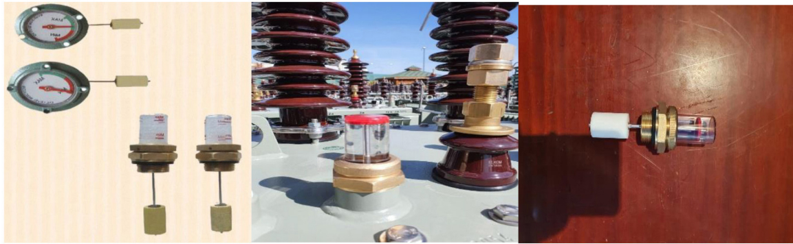
Resim 3.11. Yağ seviye göstergesi
