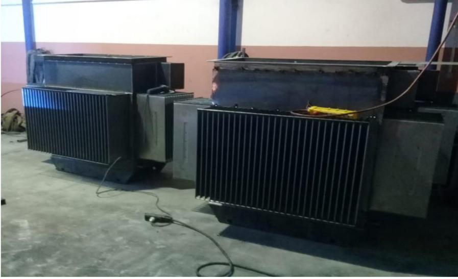
Resim 3.6. Dalga duvarlı kazanlar
