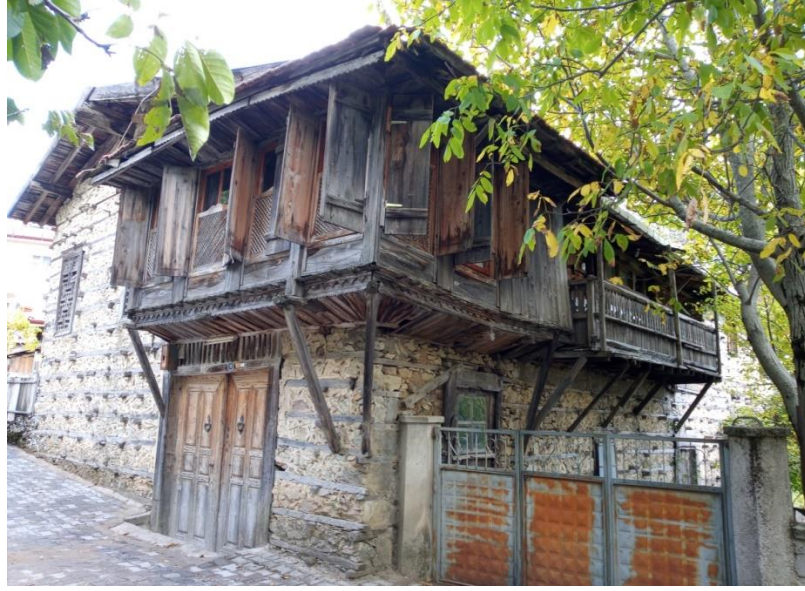
Şekil 3.6. Ayşe Naciye Balcı Konağı'nın sokak cephesinden görünüşü
