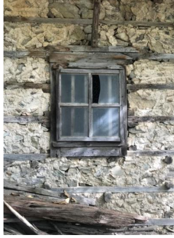
Şekil 4.86. Sağ yan (Güneybatı) cephe P3 kodlu pencere
