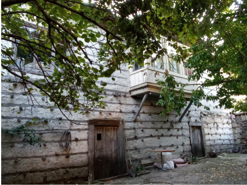
Şekil 4.40. Ayşe Naciye Balcı Konağı- sağ yan cephesi (Güneybatı)
