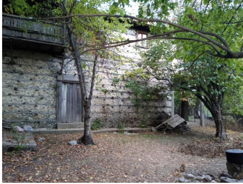
Şekil 4.42. Ayşe Naciye Balcı Konağı - sol yan cephesi (Kuzeydoğu)
