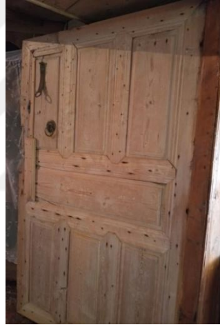
Şekil 4.83. Üst kat 1.02 (yatak odası) nolu mekan kapısı
