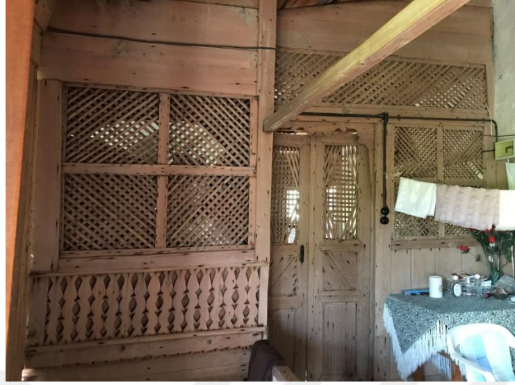
Şekil 4.52. Üst kat 1.01 nolu mekan (cumbalı oda) girişi
