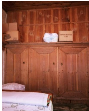
Şekil 4.90. Üst kat 1.02 (yatak odası) nolu mekan D1 kodlu dolabı
