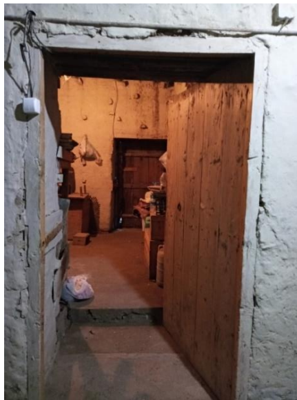
Şekil 4.46. Alt kat A02 nolu mekan (oda)
