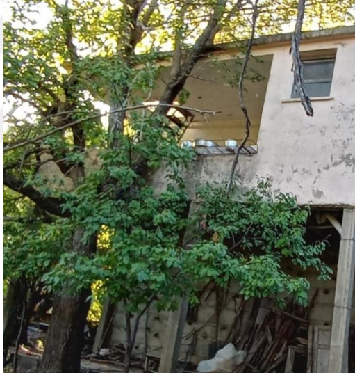
Şekil 4.67. Üst kat 1.07 nolu mekan (balkon)-2
