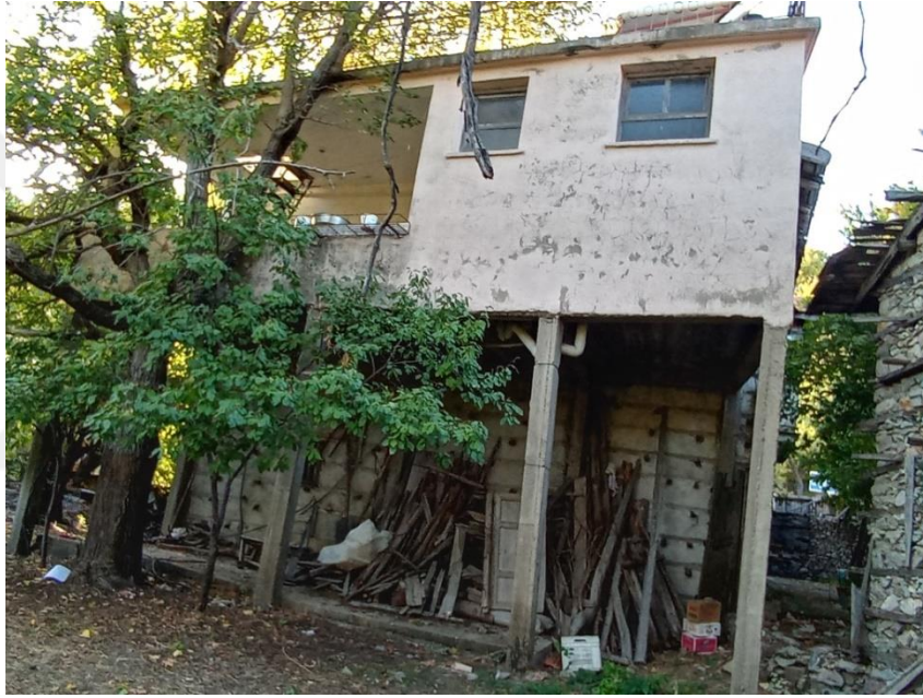
Şekil 4.38. Ayşe Naciye Balcı Konağı- Arka Cephesi (Güneydoğu)
