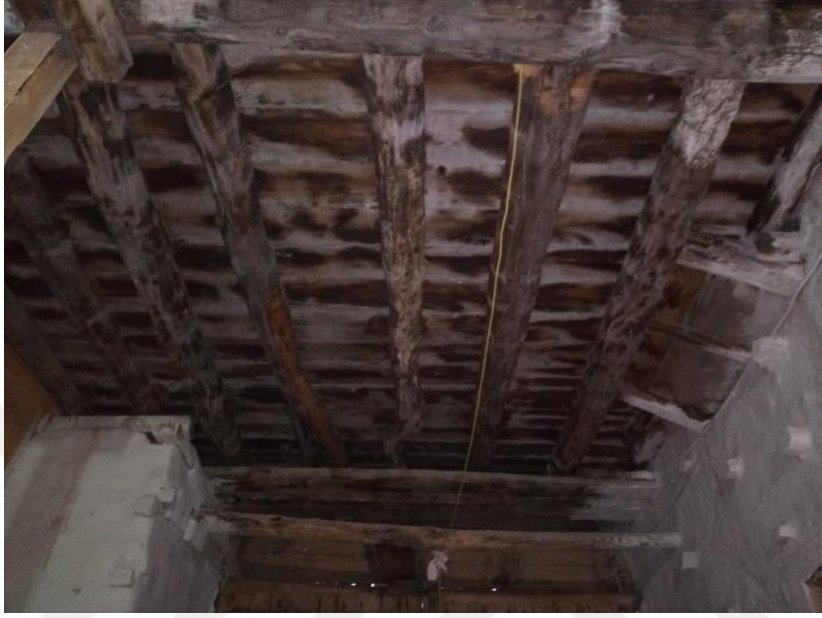
Şekil 4.96. Alt kat A01 (giriş) nolu mekan tavanı
