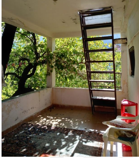
Şekil 4.66. Üst kat 1.07 nolu mekan (balkon)-1
