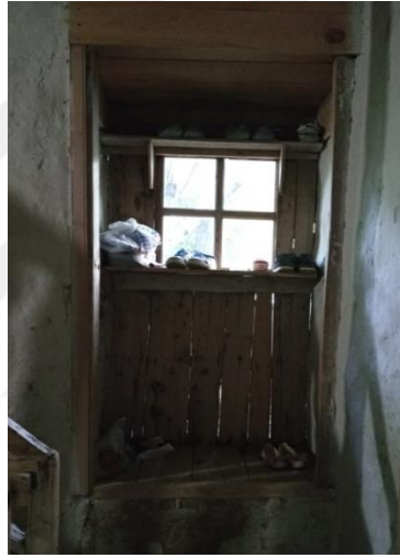
Şekil 4.87. Alt kat A01 ( giriş) nolu mekan P1 kodlu pencere
