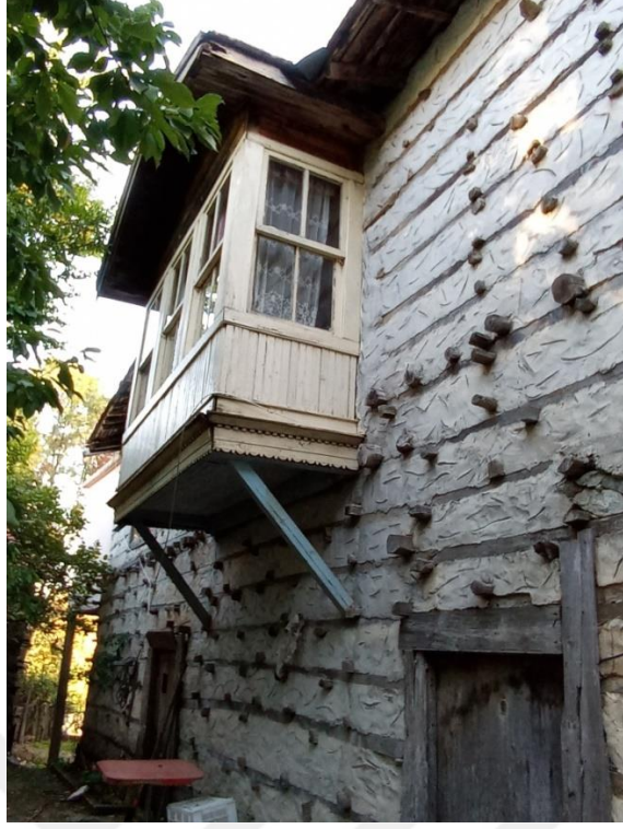
Şekil 4.39. Ayşe Naciye Balcı Konağı- sol yan cephesi (Kuzeydoğu)
