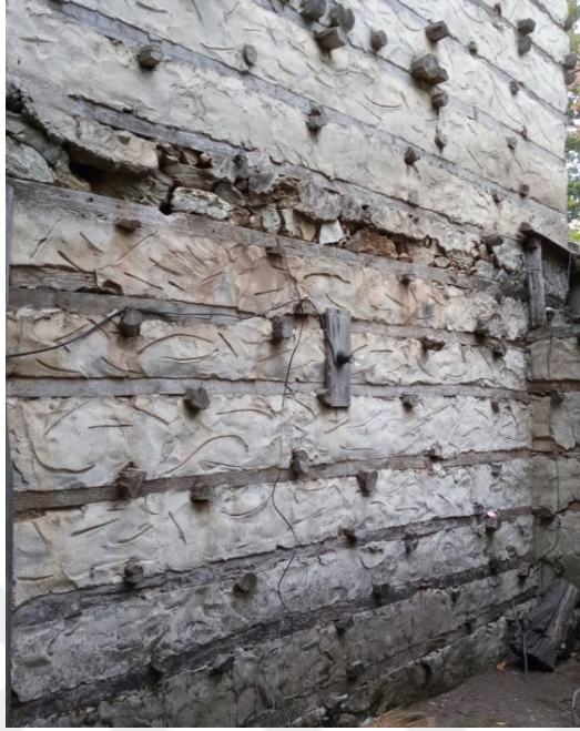
Şekil 4.74. Sol yan (Kuzeydoğu) cephe duvar örneği
