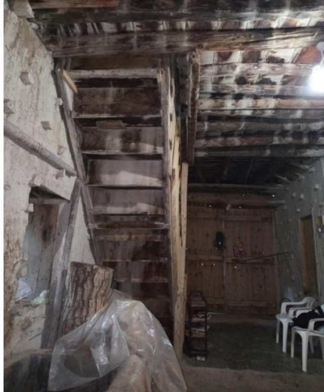
Şekil 4.44. Alt kat A01 nolu mekan (giriş)
