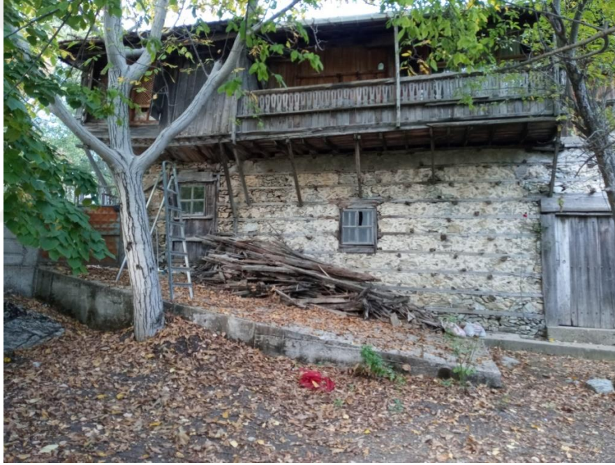
Şekil 4.41. Ayşe Naciye Balcı Konağı- sağ yan cephesi (Güneybatı)
