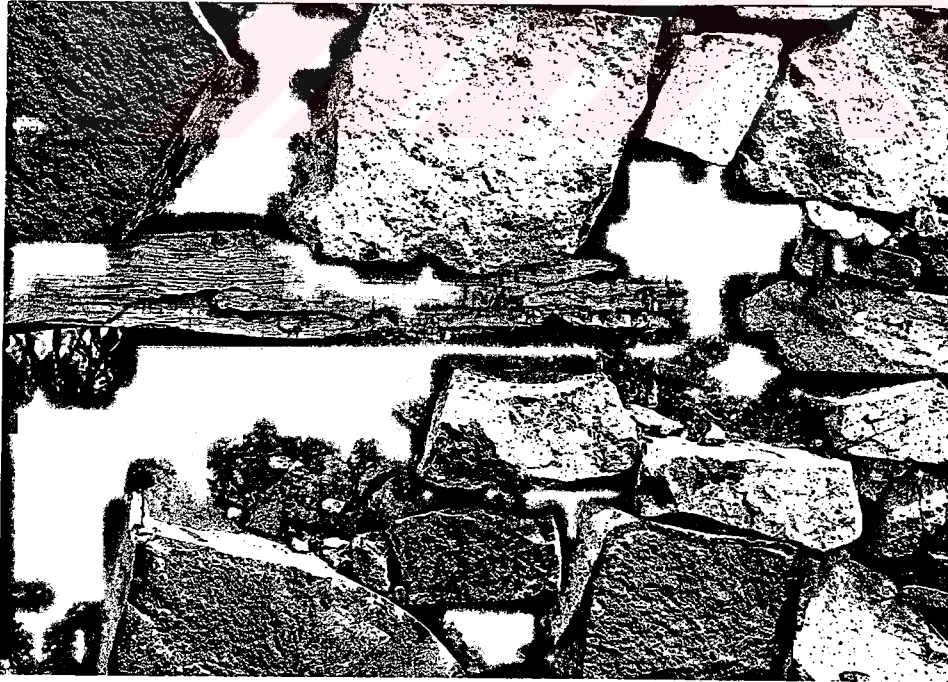
ŞEKİL 4.165 Avlu duvarındaki ahşap hatıl
