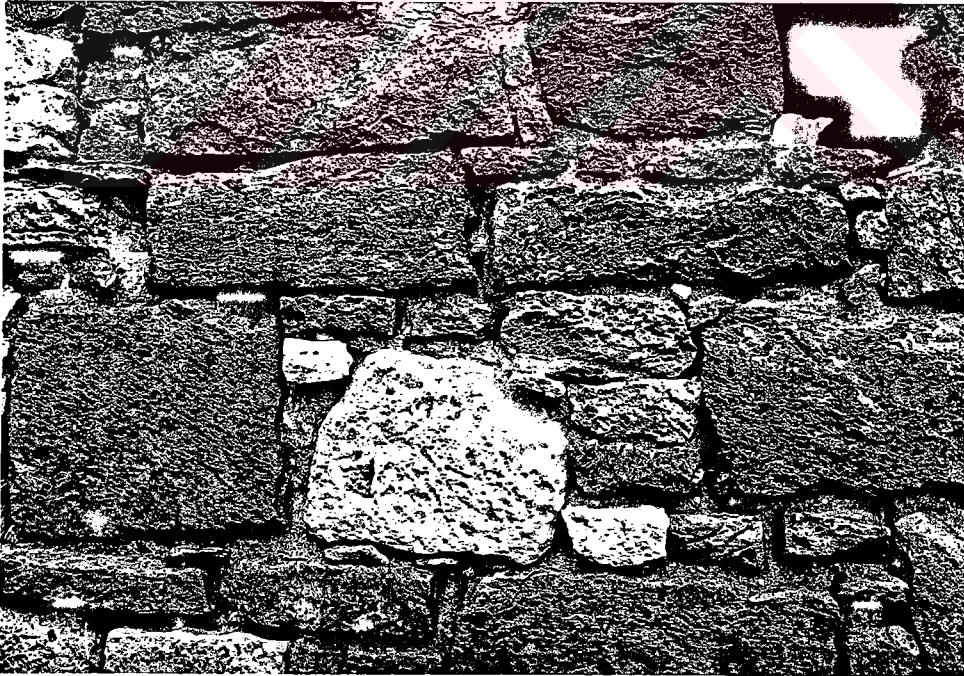
ŞEKİL 4.139 Kilise duvar örgüsünde kullanılan sarımsak taşları
