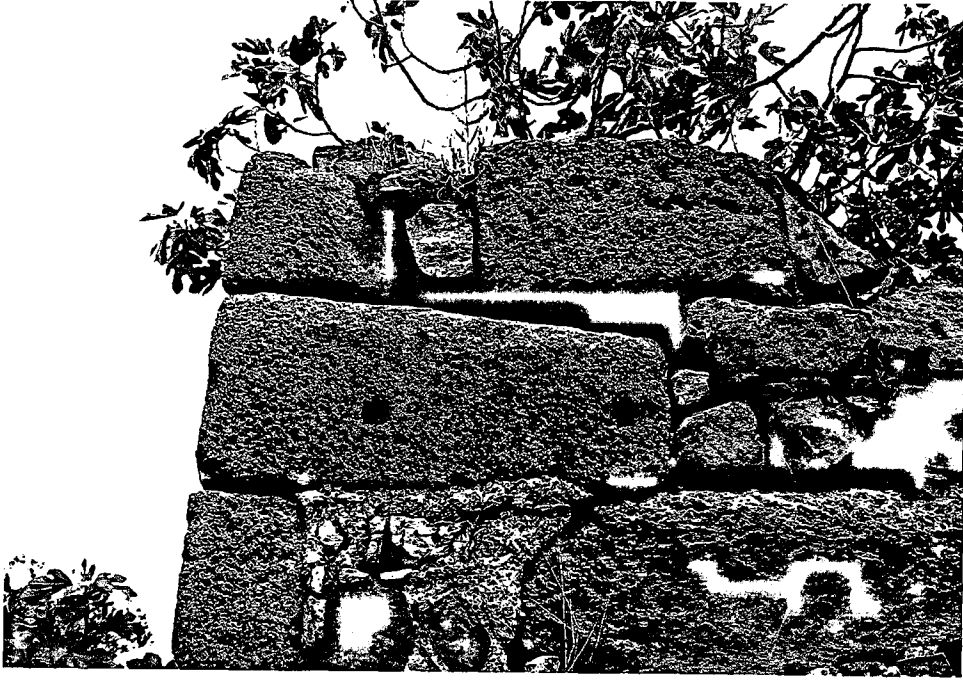
ŞEKİL 4.168 Avlu duvarında kullanılan köşe taşları
