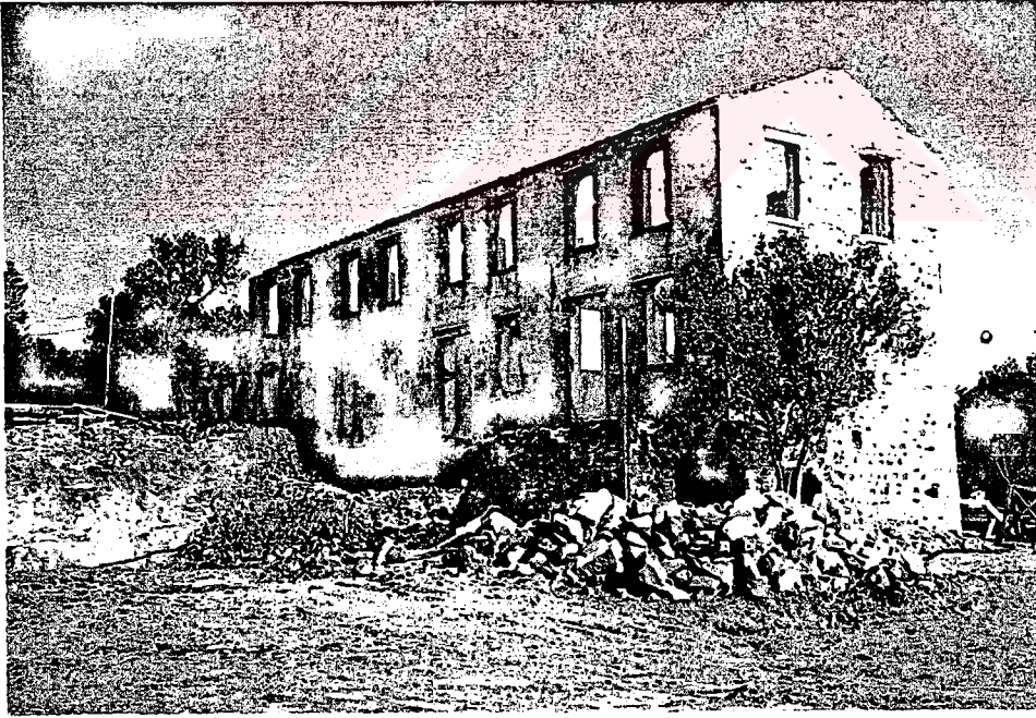
ŞEKİL 4.150 Restorasyon öncesi beş konutluk blok
