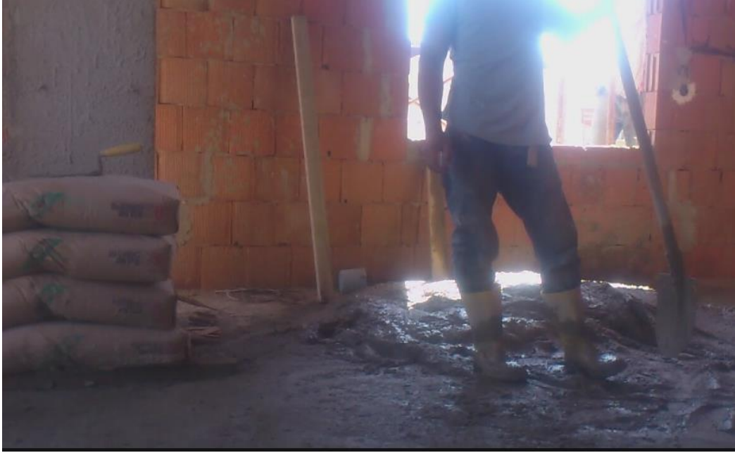
Resim 2. Geleneksel Duvar Harcınının Hazırlanması
