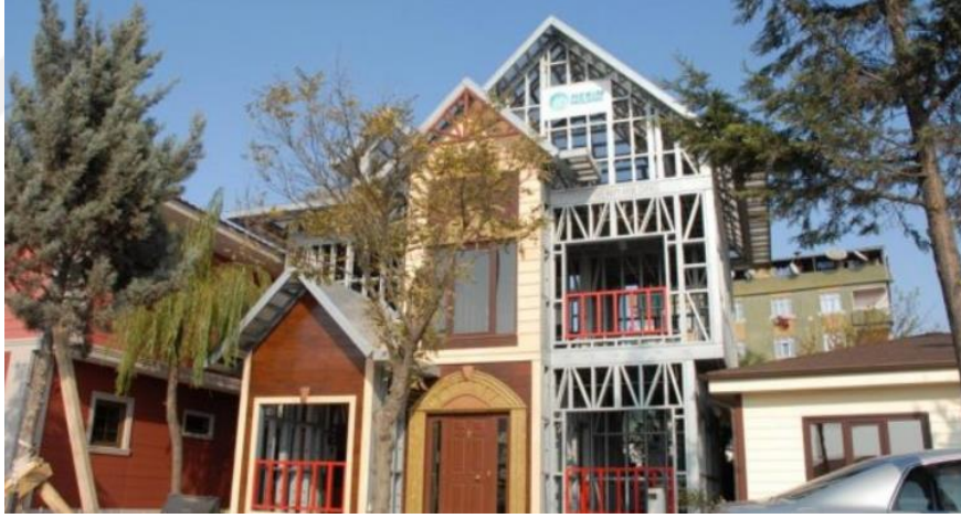
Resim 5 : Ön Yapımlı Yapı Elemanlarının Kullanıldığı Konut
