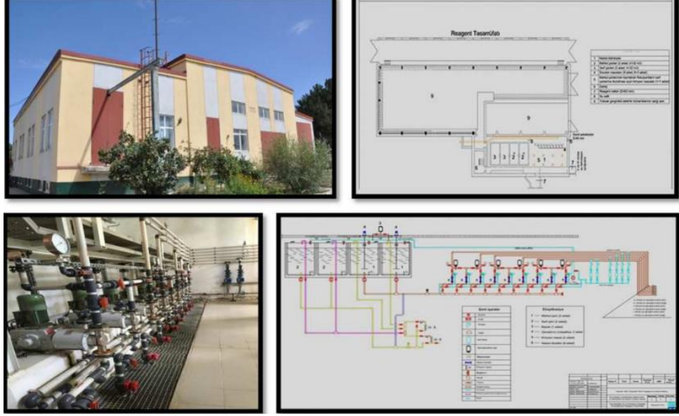
Şekil 3.5. Reaktif hazırlama binası
