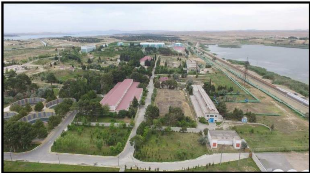
Şekil 3.4. Birinci aşama su arıtma tesisleri
