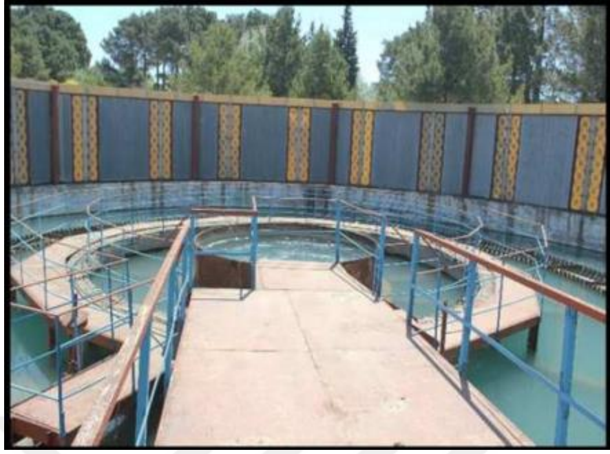
Şekil 3.8. TsNII-3 tipi askıda tortu tabakası arıtıcı grubu
