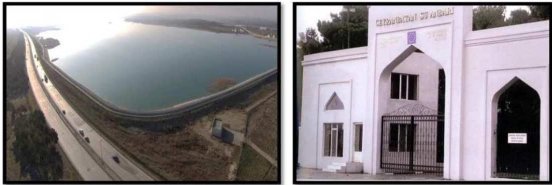
Şekil 3.2. Ceyranbatan Su Barajı
