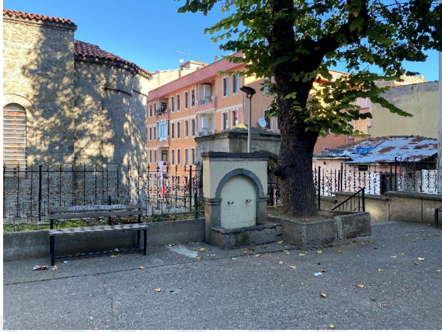
Figure 4.11. The current fountain in the garden of Hızırbey Ülkü İlköğretim Okulu, Gönülnur Demet,2023
