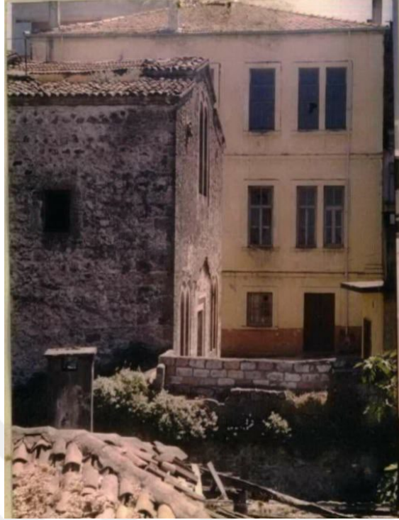
Figure 3.5. The previous version of the courtyard (source:Bozal, M. (2018). Trabzon İli Ortahisar İlçesi Hızırbey Mahallesi 42 Ada 11-12-28-29 Parseller Okul ve Salon (Kilise) Binaları Rölöve, Restitüsyon, Restorasyon Projeleri. [Architectural drawing]))
