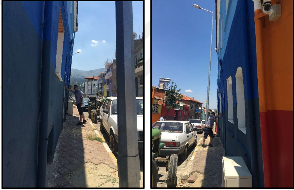
Şekil 78: Heyelanın neden olduđu yapılarıdaki eğimlenme (Babadağ İlçesi Cumhuriyet mahallesi).
