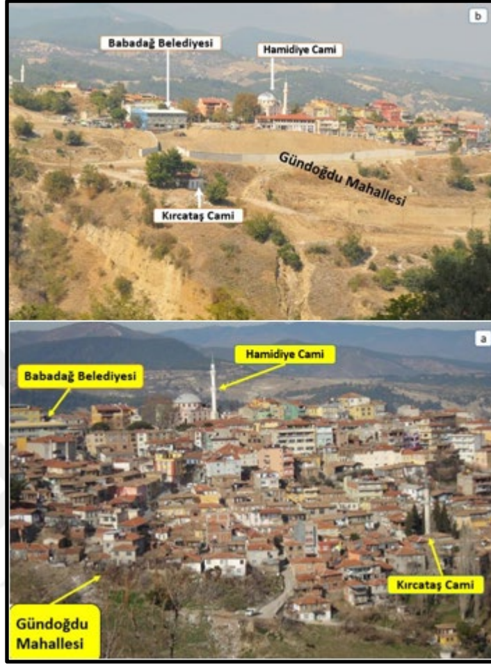
Şekil 84: a) Gündoğdu Mahallesi yıkılmadan önceki durumu, b) Gündoğdu Mahallesi'nin (Ekim), 2018 yılı mevcut
