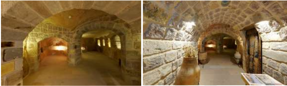
Resim 3.20. Argos in Cappadocia Otel restorasyon sırasında bulunan ve ortak kullanıma açılan ahır mekanı 2
