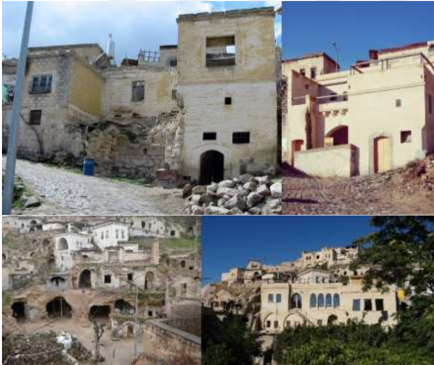
Resim 3.50. Bölgede münferit satın alınarak restorasyonu tamamlanan konut olarak kullanılan yapıların yenilenmeden önceki ve sonraki görselleri 2
