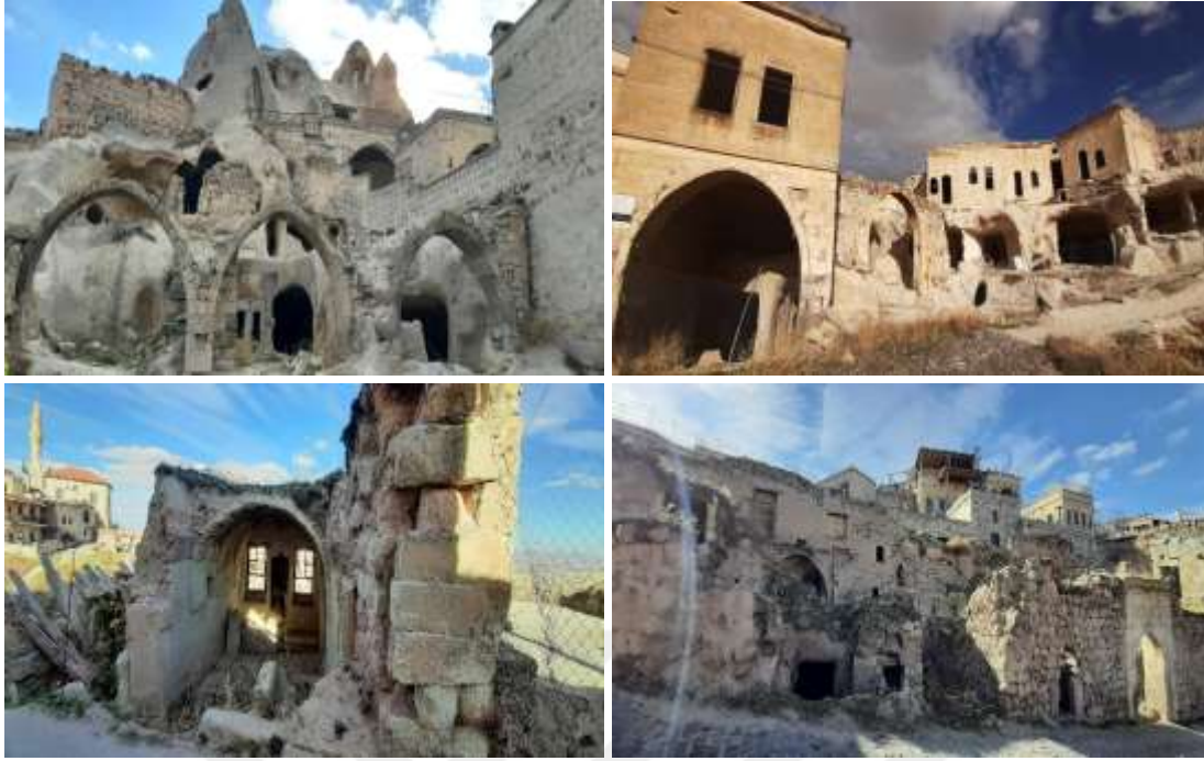
Resim 3.17. Beldede restorasyon çalışmaları devam eden konutlar (Görseller yazarın fotoğraf arşivindendir)
