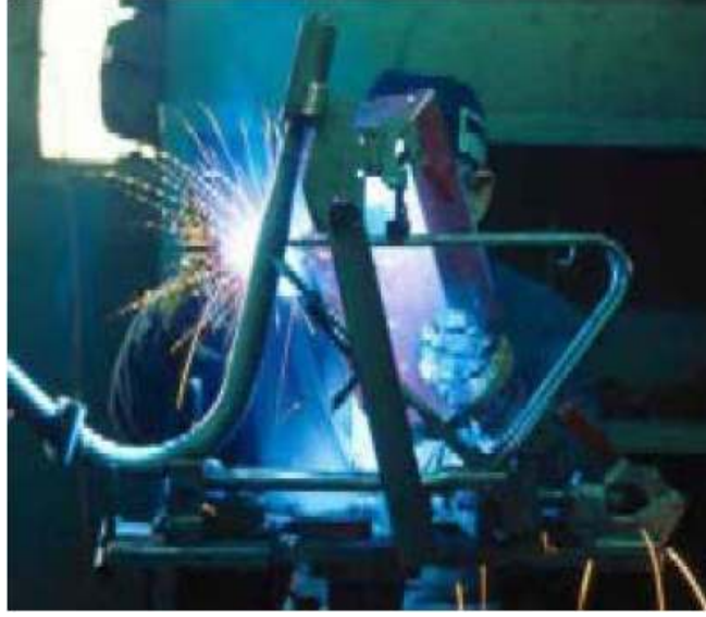
Şekil 2.9. Gazaltı kaynak uygulaması
