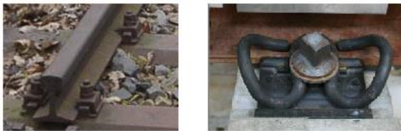
Şekil 2.6 : Rijit direkt bağlantı elemanı (soldaki), b) Elastik direkt bağlantı elemanı (sağdaki) (Ministry of Education of the Czech Republic, 2012).
