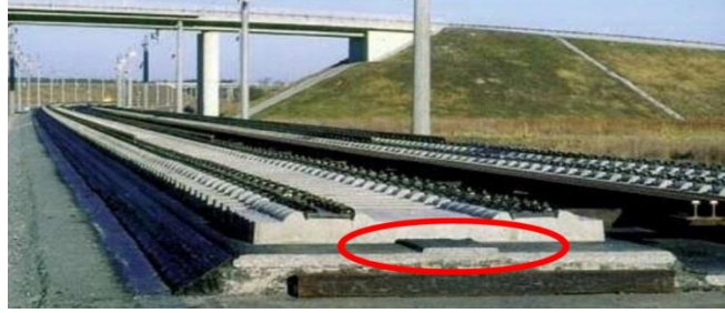
Şekil 3.21 : Hannover-Berlin Yüksek Hızlı Tren Hattı ATD sistemi (Lechner, 2011).
