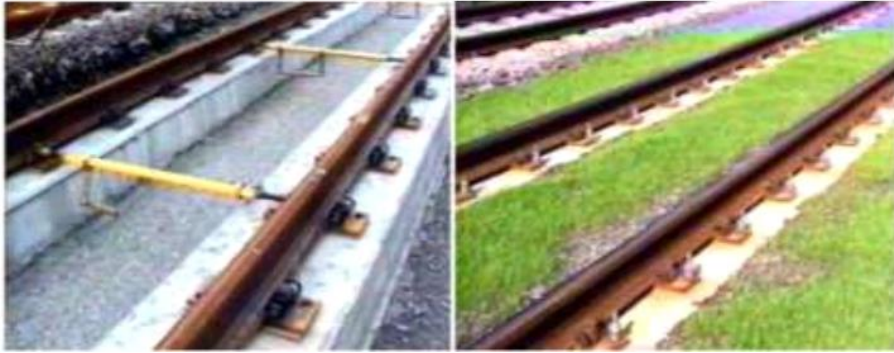
Şekil 3.38 : Rasengleis tipi üstyapı (Popovic ve diğ, 2012).
