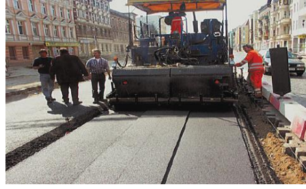
Şekil 3.20 : Berlin Tramvay Hattı ATD sistemi (EAPA, 2014).
