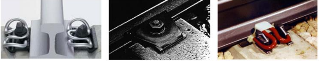
Şekil 2.7 : Elastik direkt ray bağlantı elemanları (soldaki Vossloh, ortadaki Nabla, sondaki Pandrol bağlantı sistemi) (Moderen, 2010).
