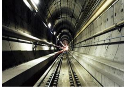
Şekil 3.15 : Manş tüneline Sonneville üstyapı sistemi ( www.eurotunnelgroup.com ).
