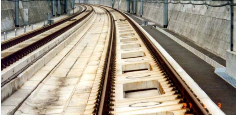
Şekil 3.32 : Shinkansen çerçeve tipi üstyapı sistemi (Takai, 2007).
