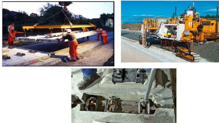
Şekil 3.34 : Bögl üstyapı sisteminin inşaatı ( www.max-boegl.com ).
