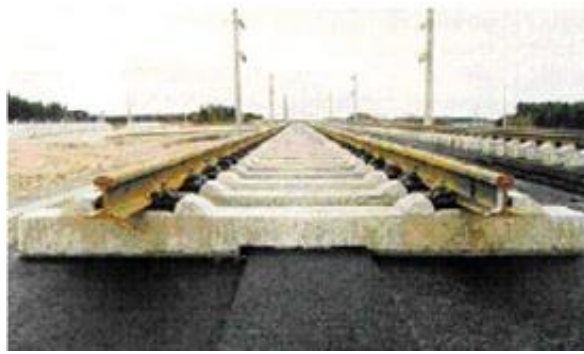
Şekil 5.6 : Monoblok traversli ATD sistemi (Mörscher, 1999)
