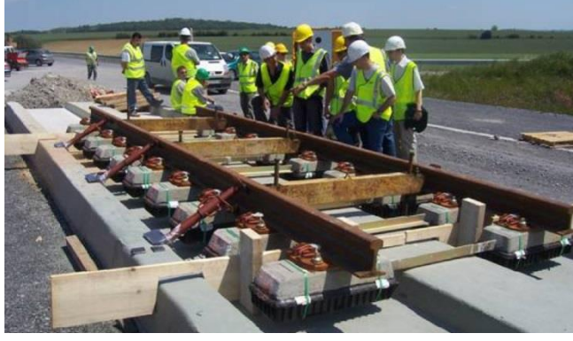
Şekil 3.13 : Stedef üstyapı sisteminin montajı (Dieleman ve diğ. 2008).
