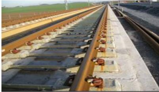
Şekil 3.14 : Stedef sisteminin tamamlanmış hali (Dieleman ve diğ. 2008).
