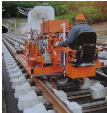
Şekil 4.12 : ATD sistemi hat geometrisi kontrolü (EAPA, 2014).
