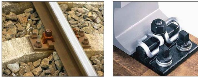
Şekil 2.5 : Rijit endirekt bağlantı elemanı (soldaki), Elastik endirekt bağlantı elemanı (sağdaki) (Ministry of Education of the Czech Republic, 2012).
