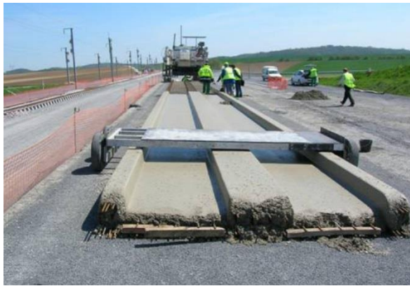
Şekil 3.12 : Stedef sistemi beton tabakanın hazırlanışı (Dieleman ve diğ. 2008).
