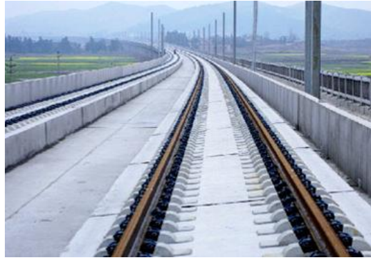
Şekil 3.4 : Xian ve Zengzhou Yüksek Hızlı Tren Hattı Züblin tipi üstyapısı (Enoekl ve Nübel, 2006).
