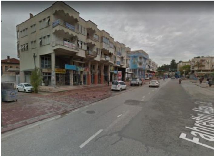
Şekil 4.22. Balbey Mahallesi Doğu Yönünden Görünüm (Anonim 8)
