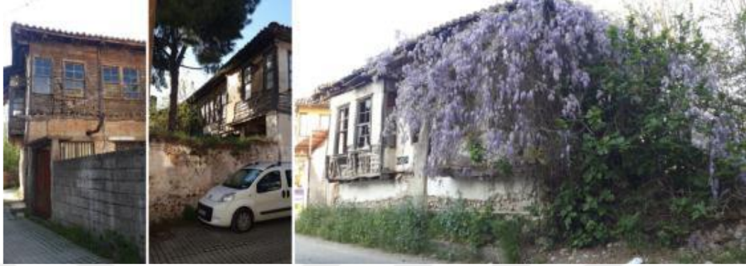
Şekil 4.9. Yığma taş üstü bağdadi yapım tekniği örneği
