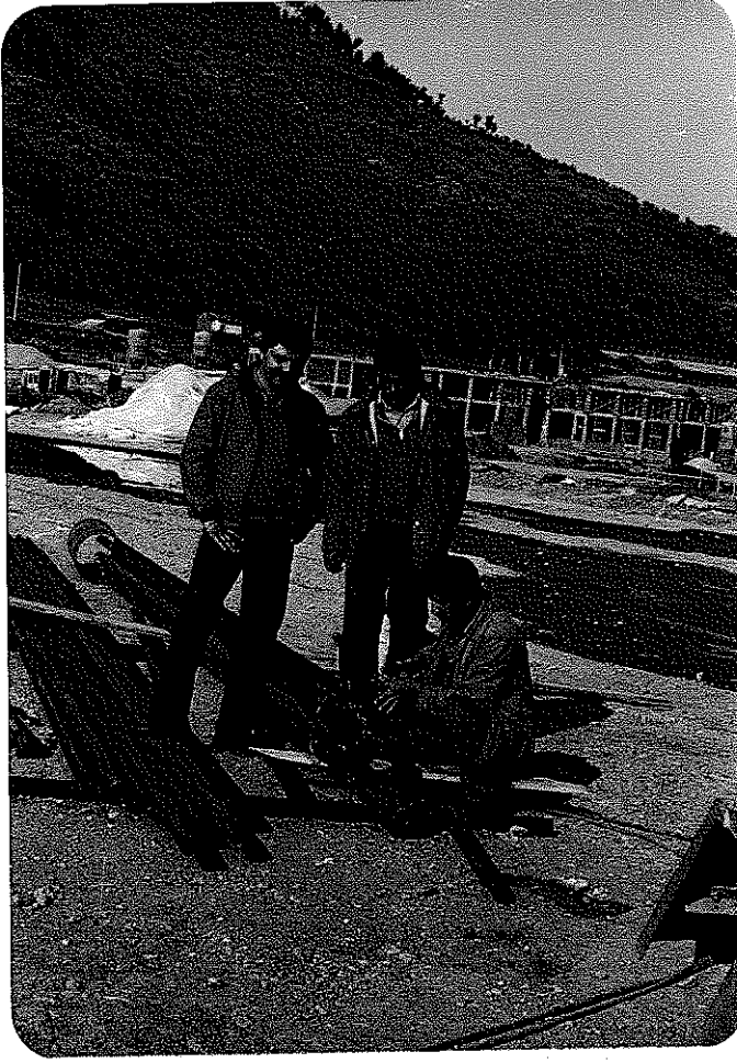
Foto-3 Isı üretim kuyularına indirilen " U " borularının hazırlanışı
