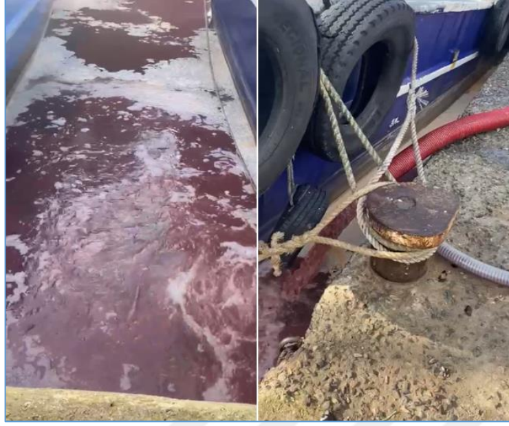
Şekil 1.7. Balık Basıcı Su Pompası ile Atık Su Denize Deşarjı
