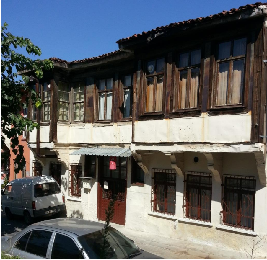
Şekil 4.13 İki yandan asimetrik cumbalı cephe örneği
