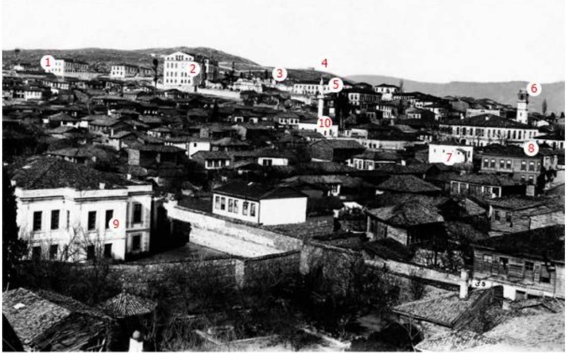
Şekil 2.15 1928 yılı Kasaplar Camiiden Hacı İlbey, Dumlupınar ve Aygören mahalleleri (Balıkesir Büyükşehir Belediyesi Kent Arşivi, 2014). Eren (1993) kitabındaki bilgiler kullanılarak işaretlenen yapılar; 1-Asker Hastanesi, 2-İdadi Binası (Günümüzde Balıkesir Üniversitesi Güzel Sanatlar Fakültesi), 3-Hıristiyan Mezarlığı (1930'dan bu yana Çamlık Rekreasyon Alanı), 4-Ramazan Topu Kulübü, 5-Öğretmen Okulu Müzik Salonu, 6-Saat Kulesi, 7-Eski Hapishane, 8-Eski Hükümet Konağı, 9-Uhuvvet Mektebi (Günümüzde Rehberlik ve Araştırma Merkezi. Müdürlüğü)
