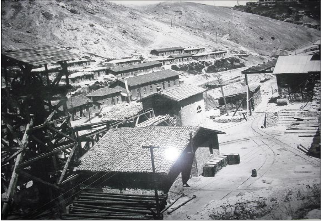
Şekil 7.1: 1901 yılında Fransızlara ait Balya Pb-Zn İşletmeleri'ne ait idari binalar ve yer altı üretim galerisi giriş kuyusu.
