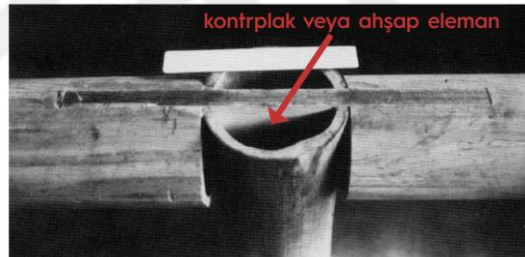
Şekil 29. İçten guseli bağlantılar (ITCR bağlantısı) (Phanratanamala, 2014)
