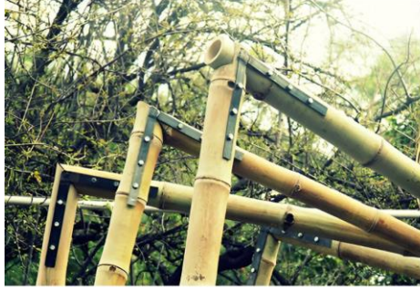
metalden yapılmış L şeklindeki elemanlar
