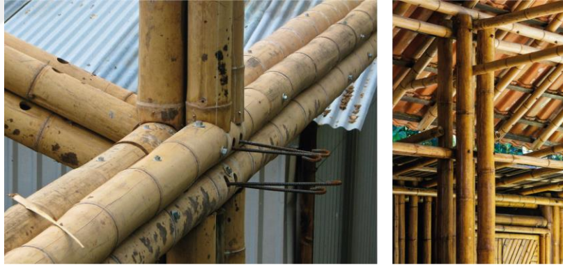
Şekil 33. Cıvatalı bağlantılar (URL-17, 2024; Stevens, 2024)
