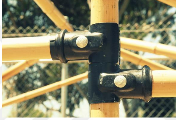
Şekil 37. Kelepçeli birleşimler (Vahanvati, 2024)
