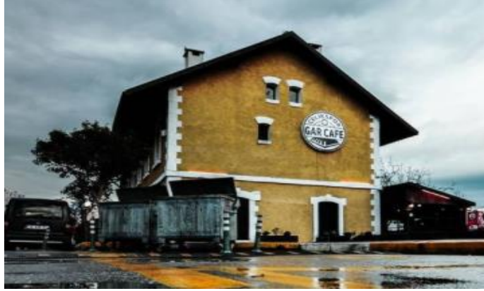
Fotoğraf 24. Çelik Restoran (Eski Gar Binası)
