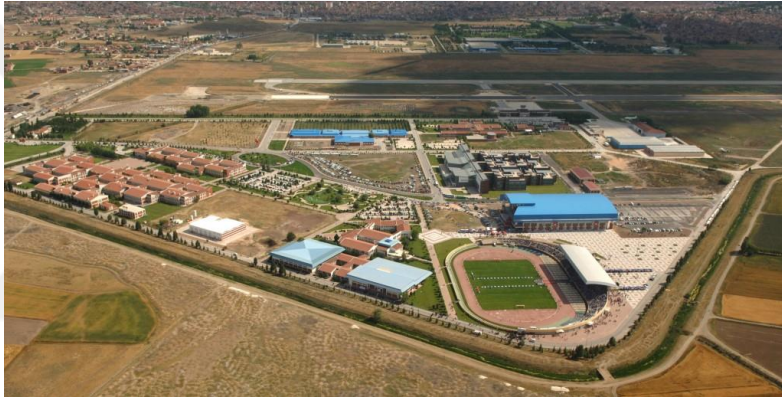
Şekil 3-19: Anadolu Üniversitesi Eskişehir
