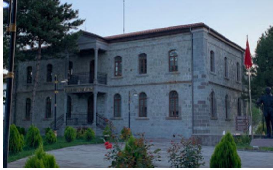
Resim 2.3.16. Kalecik Belediyesi Hizmet Binası ön cephesi, (Google haritalar, Erişim yılı 2022)
