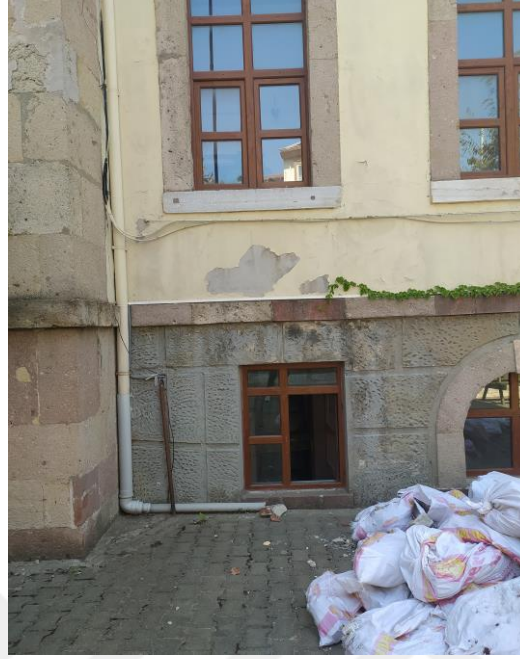
Resim 3.5.7. Cephede oluşmuş olan bozulmalar, 2022
