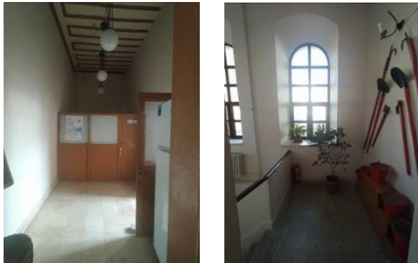
Resim 3.4.33. Redif binası Z10 mekanı, 2022
