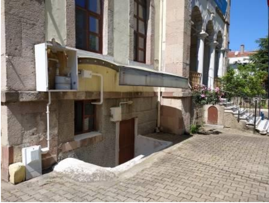
Resim 3.4.56. Redif binası giriş cephesi bodrum kat bağlantısı, 2021
