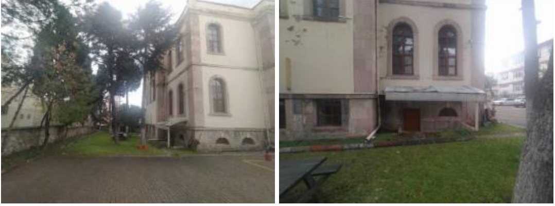
Resim 3.4.66. Redif binası arka cephe bahçe ilişkisi, 2021
