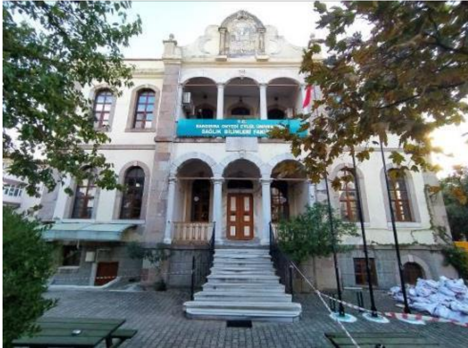
Resim 3.4.54. Redif binası Giriş Cephesi, 2021
