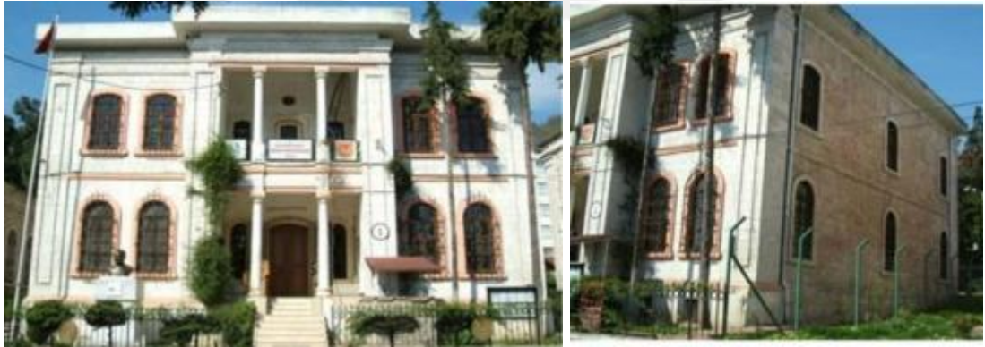
Resim 2.3.32. Ordu Askerlik Şubesi ön (a) ve yan (b) cephesi (Özgen,2013)
