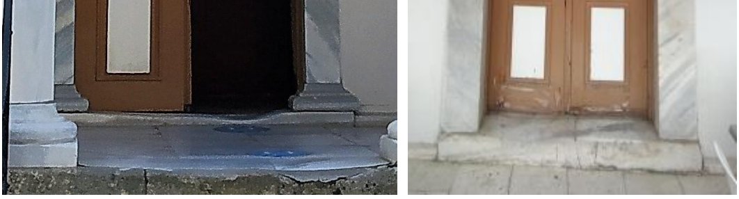
Resim 3.5.5. Giriş (a) ve balkon (b) kapı denizliklerinde aşınmalar, 2022
