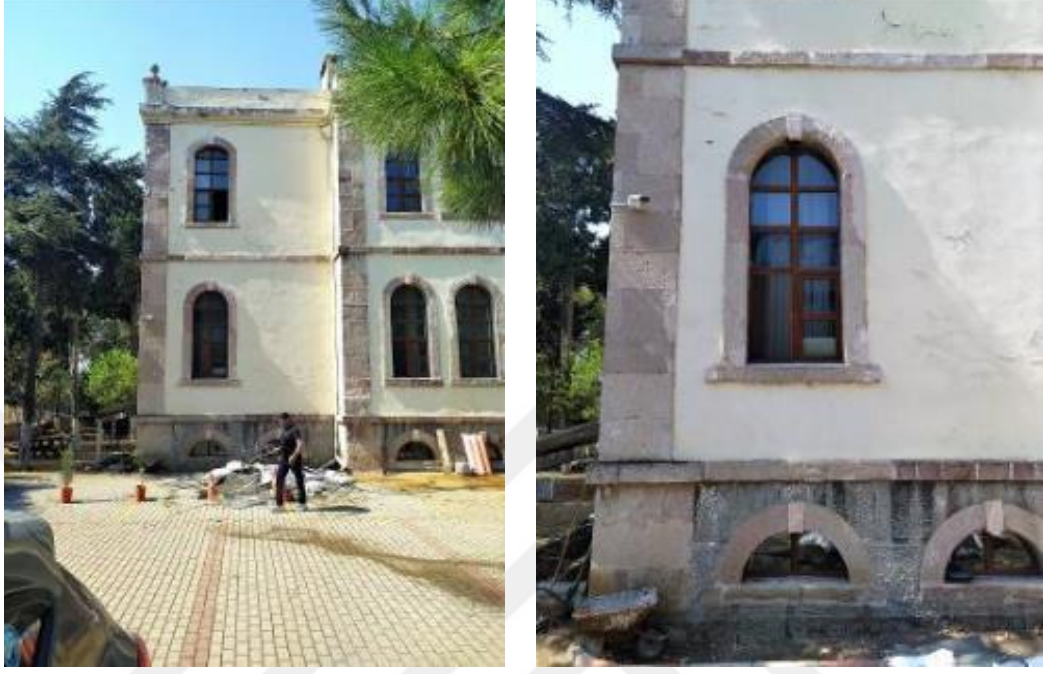
Resim 3.4.64. Redif binası doğu cephesi, 2021
