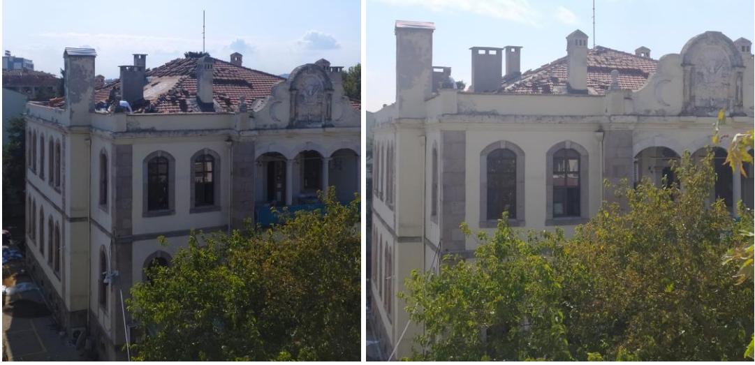
Resim 3.4.51. Yapının çatı örtüsü, 2021
