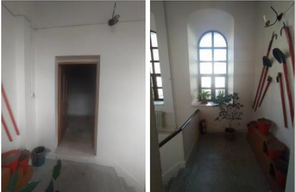
Resim 3.4.20. Redif binası Z01 mekanı iki kollu merdiven geçiş holü, 2022
