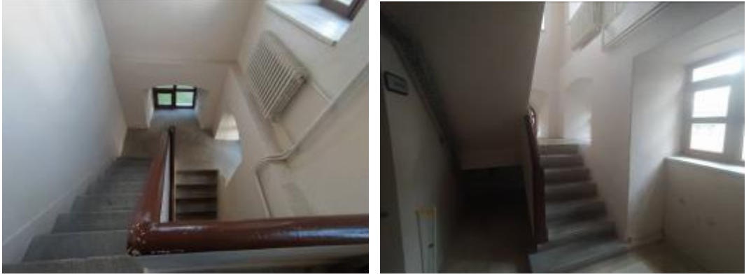
Resim 3.4.21. Redif binası Z01 mekanı bodrum katı bağlantı merdiveni, 2022
