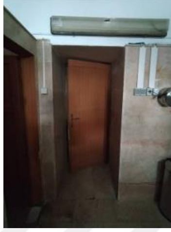
Resim 3.4.13. Redif binası B11 mekanı, 2022
