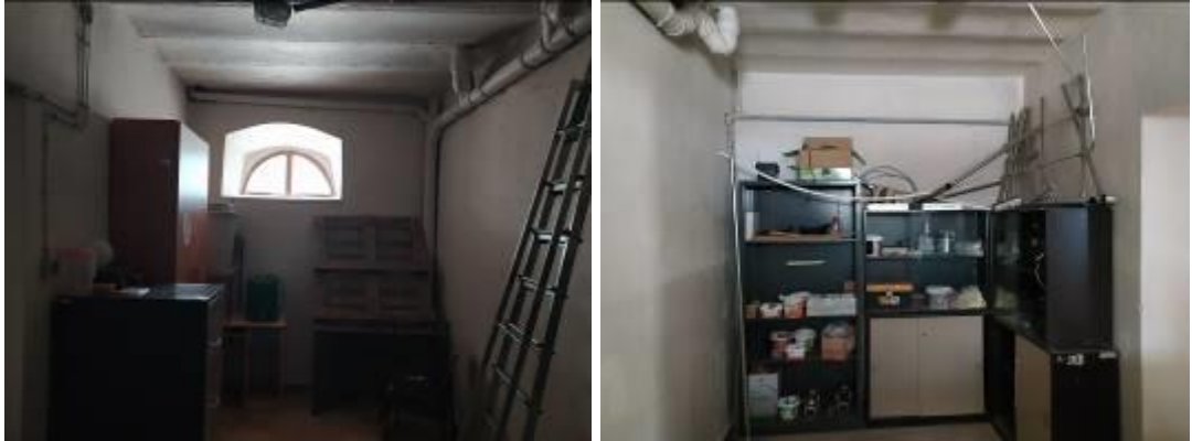
Resim 3.4.12. Redif binası B10 mekanı, 2022
