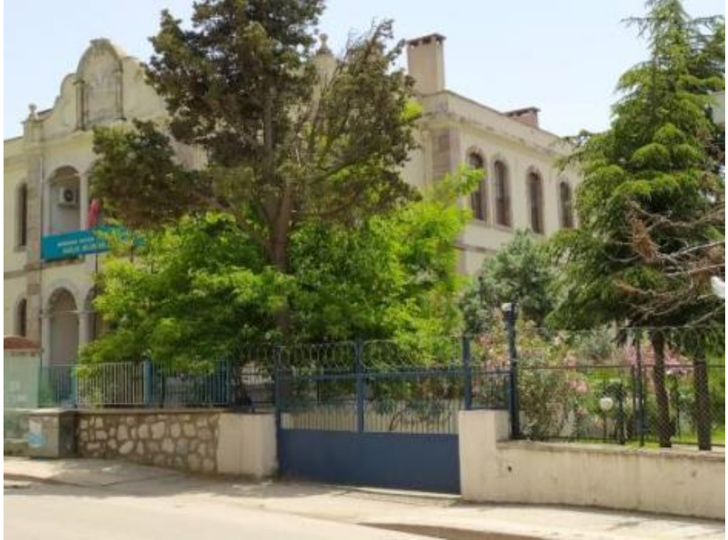
Resim 3.4.62. Redif binası batı cephesi, 2021
