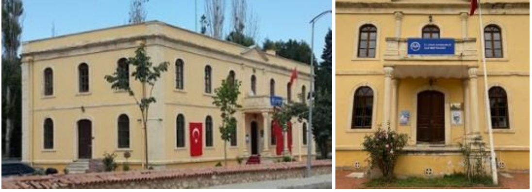
Resim 2.3.14. Daday İlçe Müftülük Binası giriş (a) ve yan cepheleri (b) (Özgen, 2013)
