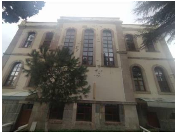
Resim 3.4.65. Redif binası arka cephe, 2021
