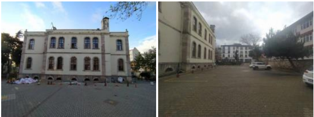
Resim 3.4.63. Redif binası doğu cephesi, 2021
