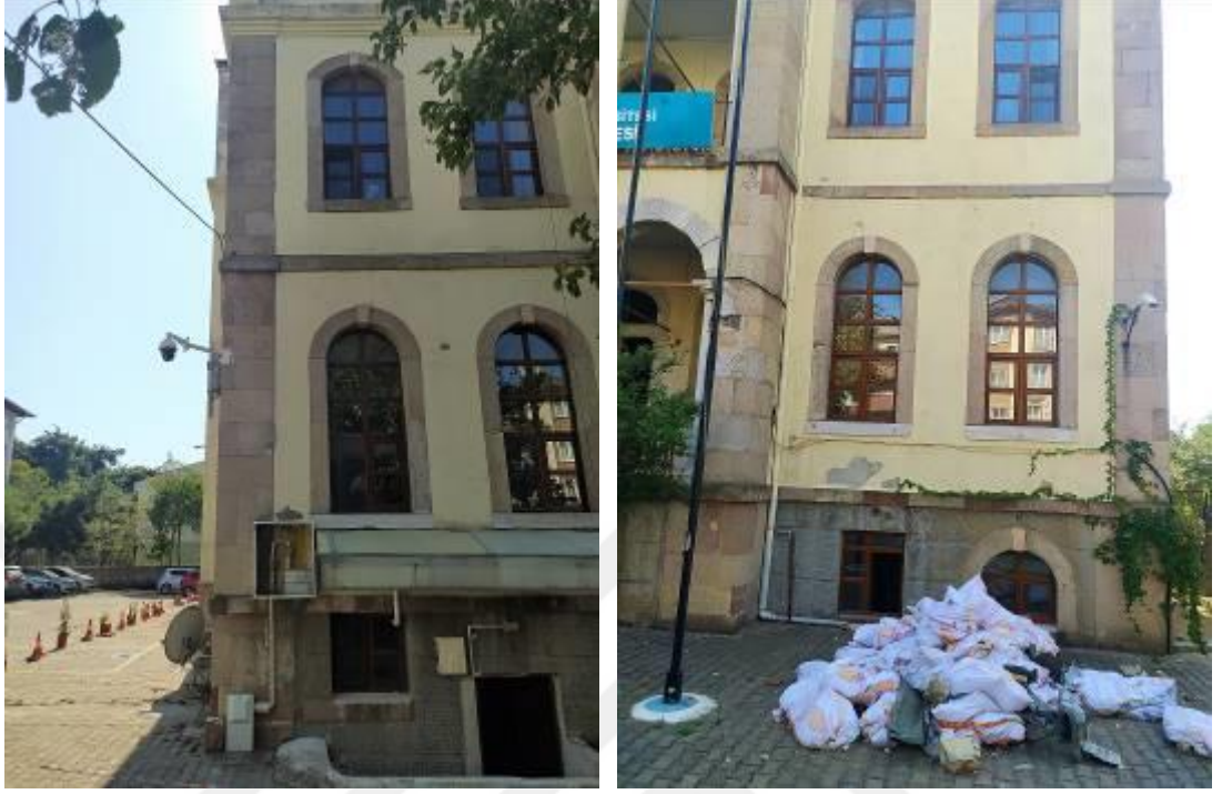
Resim 3.4.59.Redif binası giriş cephesi, 2021
