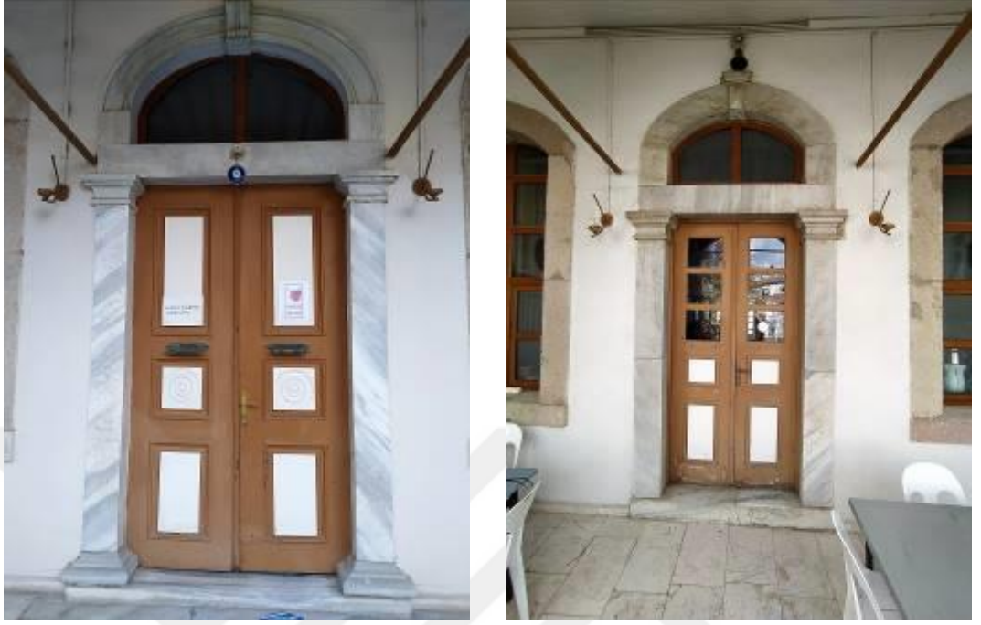
Resim 3.4.55. Redif binası giriş kapısı (a), balkon kapısı (b), 2021
