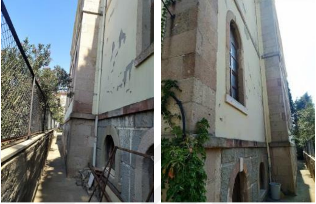
Resim 3.4.61. Redif binası batı cephesi, 2021
