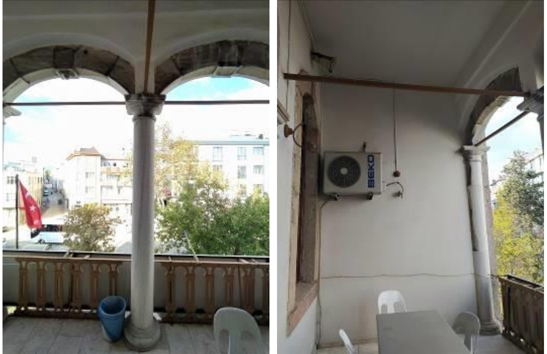
Resim 3.4.60. Redif binası balkon, 2021
