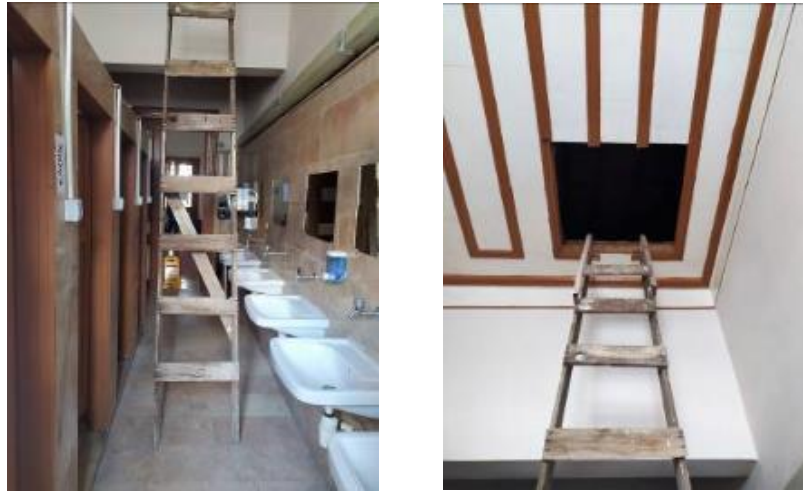
Resim 3.4.47. Redif binası 109 mekanı, 2022
