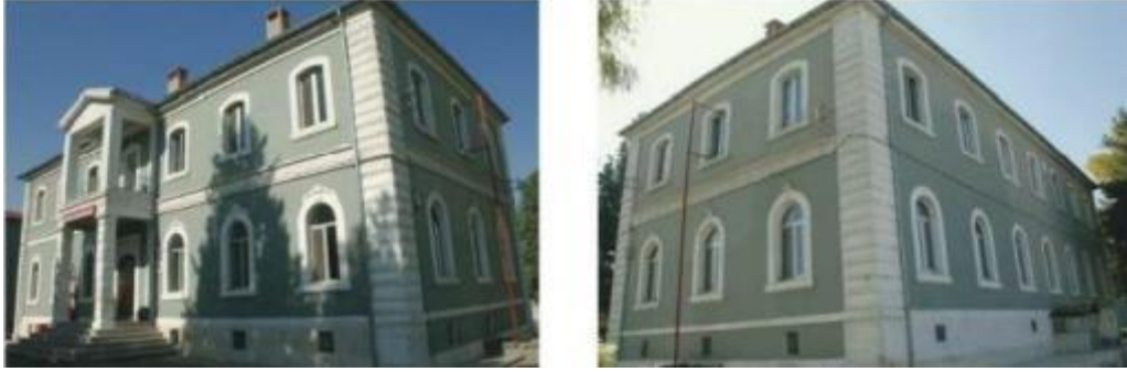
Resim 2.3.22. Burdur Merkez Komutanlığı Binası giriş (a) ve yan cepheleri (b) (Özgen, 2013)
