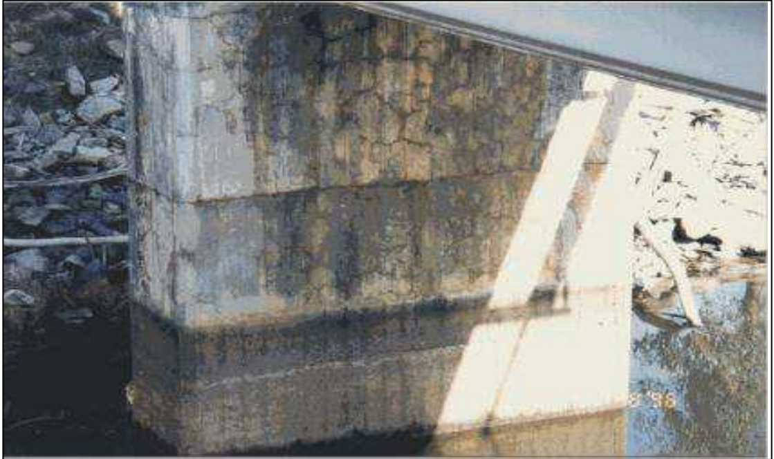
Şekil 3.4. ASR'ye maruz kalmış beton örneği (URL-3, 2014)
